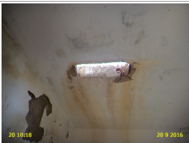
Foto 3 – PT-02: ausência de iluminação.
