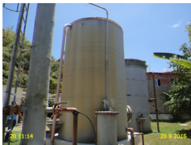
Foto 15 – ETE: reator UASB sem identificação.
