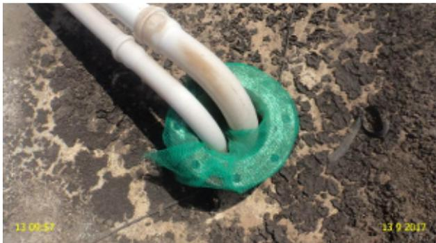
**Foto 10** – RAP-06: tubulação de ventilação inadequada.
