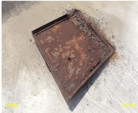
**Foto 23** - RAP-06: tampa de inspeção em processo de corrosão.
