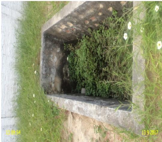
**Foto 22** - RAP-06: caixas de inspeção/passagem sem tampa ou grade de proteção.
