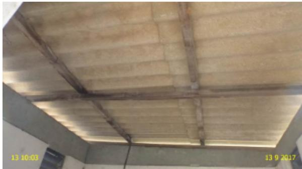
**Foto 3** – PT-02: casa de abrigo do quadro de comando sem iluminação
