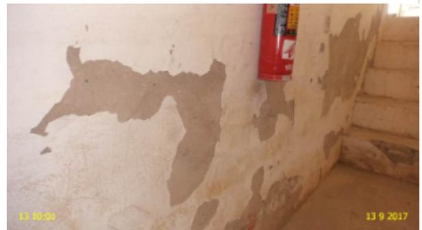
**Foto 19** – EEAT-02: parede com reboco e pintura deteriorados.
