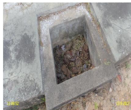
**Foto 21** – RAP-06: caixas de inspeção/passagem sem tampa ou grade de proteção.
