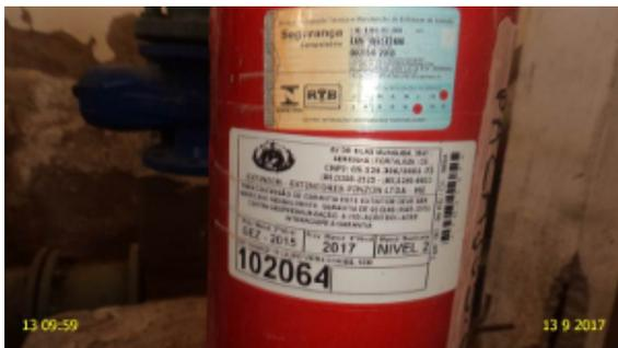
**Foto 8** – EEAT-02: extintor de incêndio com data de validade da recarga vencida.
