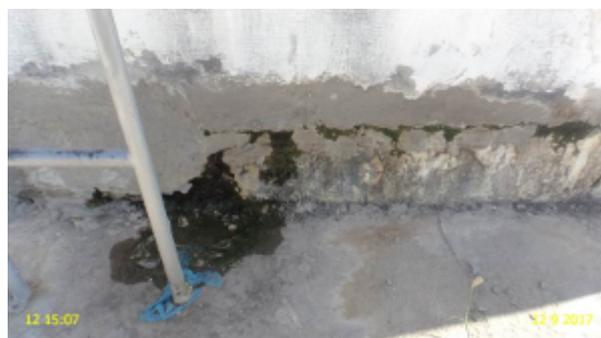
**Foto 15** – ETE Geraldo Magela: decanto digestor com sinais de vazamento.
