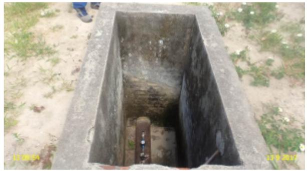
**Foto 17** – AAT: caixas do medidor proporcional sem tampa ou grade de proteção.
