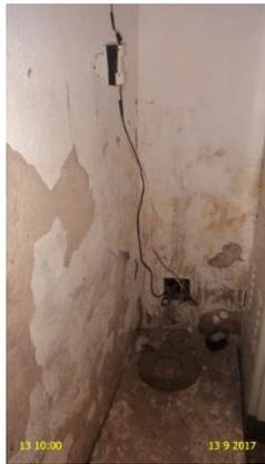
**Foto 6** – EEAT-02: instalações elétricas inadequadas e parede com reboco e pintura deteriorados.
