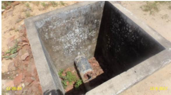
**Foto 18** – AAT: caixa da estação pitométrica sem tampa ou grade de proteção.
