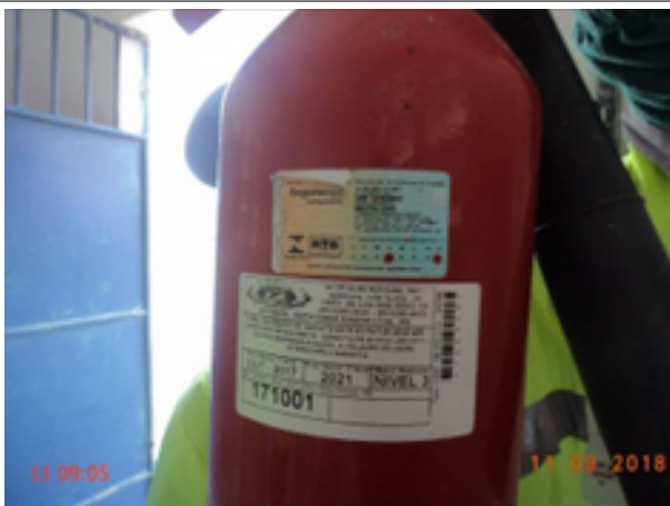
Foto 3 - O extintor de incêndio da elevatória EECS-01 está com a recarga vencida.
