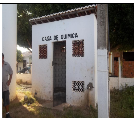
Foto 21 – Vista frontal da Casa de Química da ETA de Bela Cruz.
