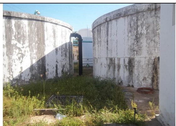
Foto 55 – RAP-02: vegetação na área de localização do reservatório.
