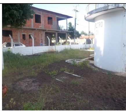
Foto 23 – Pátio externo da ETA, em péssimas condições de limpeza.
