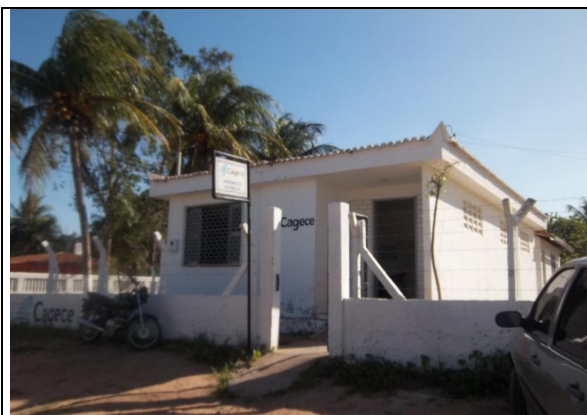
Foto 80 – Vista externa do escritório/loja de atendimento/almoxarifado.
