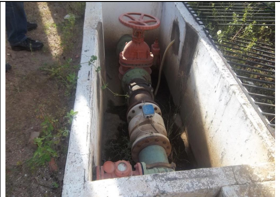
Foto 64 – Macromedidor na chegada do REL-01 e tomada do carro pipa.
