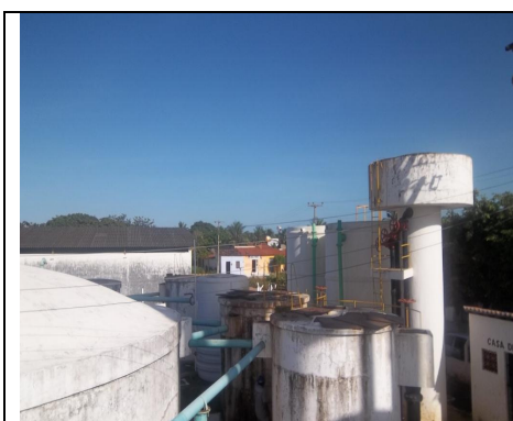
Foto 20 – Vista geral dos filtros da ETA de Bela Cruz.
