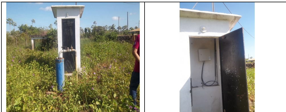
Foto 4 – PT-s/n (2º poço): ausência de identificação.
