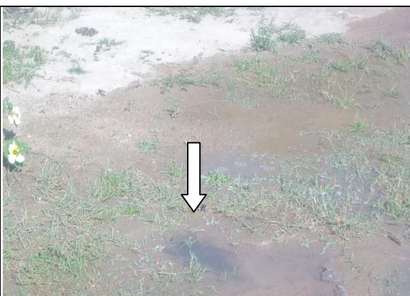
Foto 71 – Vazamento localizado na Rua Nicolau Peixoto.
