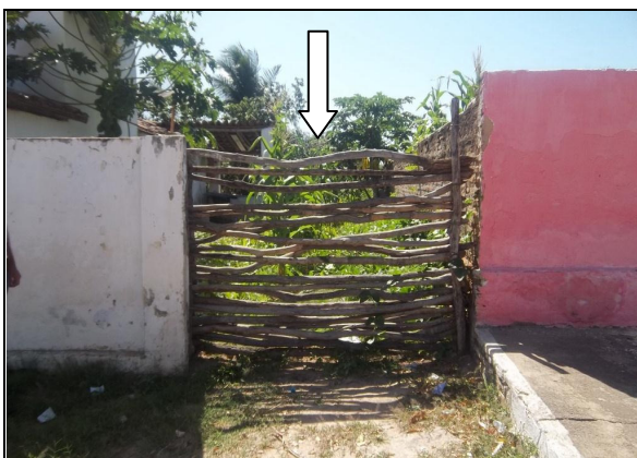
Foto 70 – Registro de descarga localizada na Rua Nicolau Peixoto, vizinho ao nº 49 (SMS) – Centro.
