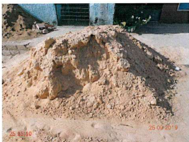
Foto 38 – RDA (Sede): registro de descarga soterrado na Praça das Carnaúbas.
