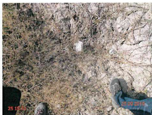
Foto 39 – RDA (Sede): registro de descarga soterrado na Rua dos Franceses.
