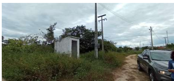
Foto 3 - Captação Moraújo (Rio Coreáú): Isolamento da área, iluminação local defeituosa ou inadequada com lâmpadas queimadas e/ou em falta na casa de apoio.
