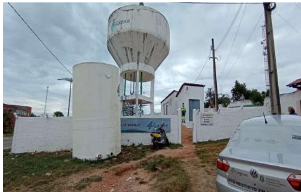
Foto 22 - ETA de Moraújo - Filtro em espera de instalação.
