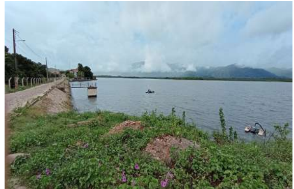
Foto 2 - Captação Várzea da Volta: Sem placa indicativa de área restrita ao abastecimento público.
