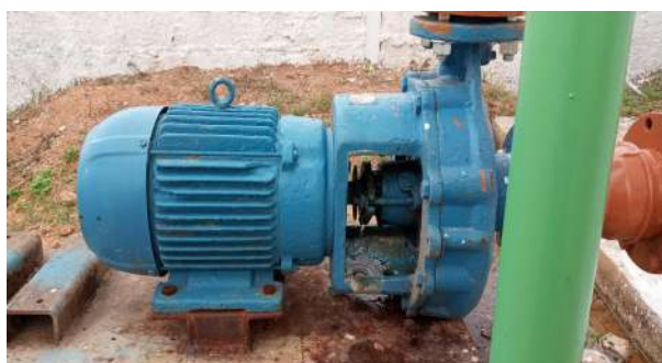
Foto 9 - ETA de Moraújo - Filtro com escada inadequada.
