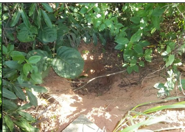
**Foto 73** – Caixa de inspeção de registro de descarga na Rua Francisco José Esteves – Coaçu: soterrada e sem tampa.
