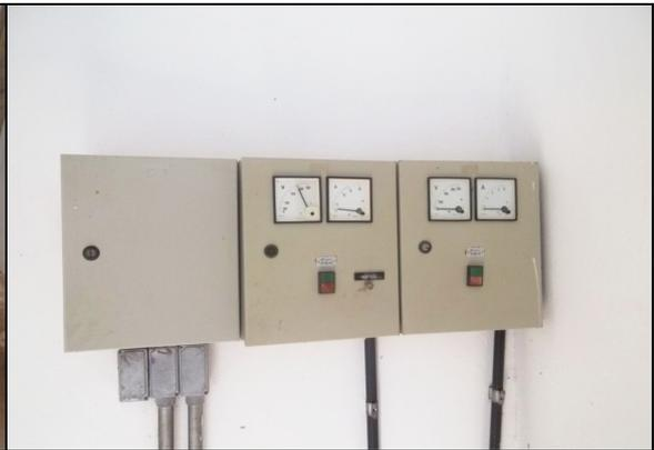
**Foto 38** – Quadros de comando da EEAT-02 sem horímetro instalado.
