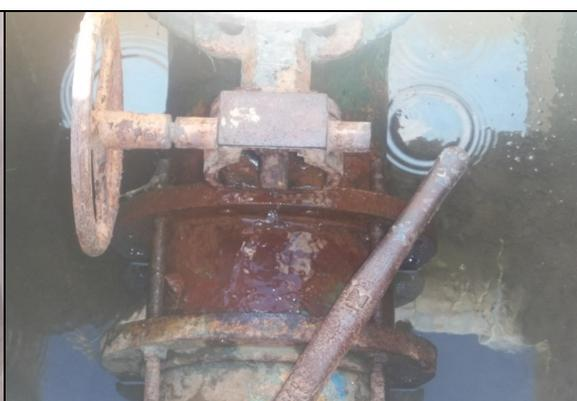
**Foto 18** – Filtro 2: tubulação de entrada apresentando vazamento .
