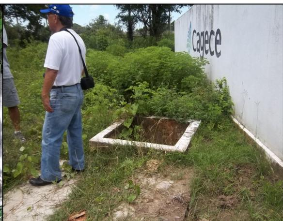
**Foto 68** – Caixa de inspeção sem tampa na adutora de água bruta.
