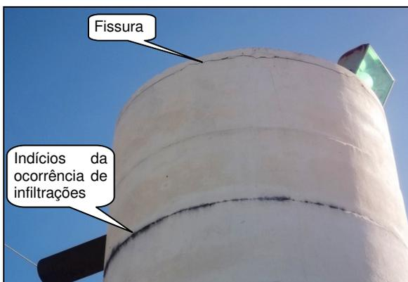
**Foto 13** – Torre de equilíbrio: fissura e indícios da ocorrência de infiltrações.
