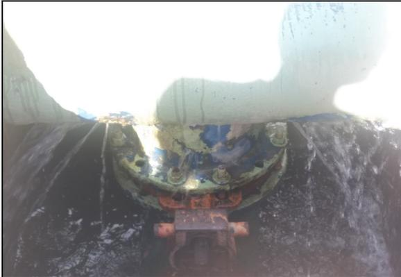
**Foto 19** – Filtro 3: tubulação de entrada apresentando vazamento .
