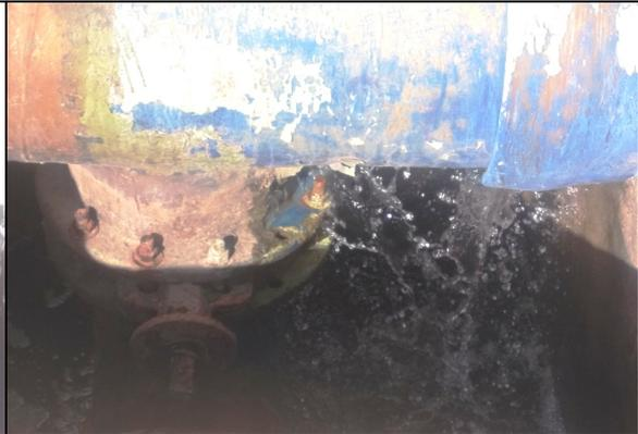
**Foto 20** – Filtro 4: tubulação de entrada apresentando vazamento .
