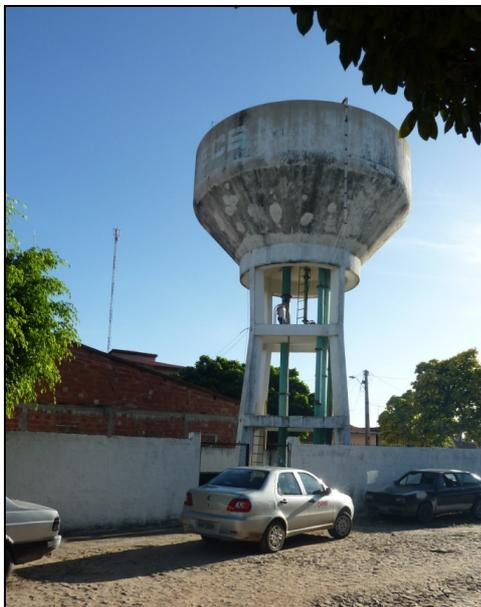
**Foto 49** – REL-01: ausência de identificação e pintura deteriorada.
