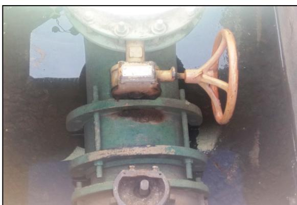
**Foto 17** – Filtro 1: tubulação de entrada apresentando vazamento .
