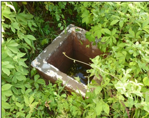
**Foto 59** – REL-02: caixa de inspeção inundada e sem tampa.
