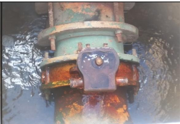
**Foto 22** – Filtro 6: tubulação de entrada apresentando vazamento .
