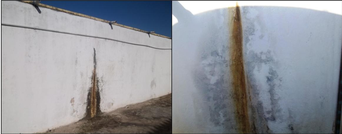
**Fotos 47 e 48** – RAP-01: fissuras e ocorrência de infiltrações nas laterais da estrutura.
