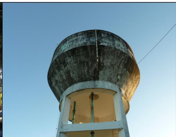
**Foto 56** – REL-02: pintura deteriorada.
