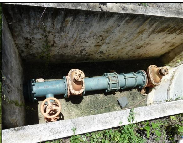
**Foto 66** – Caixa de quebra de pressão: caixa de inspeção sem tampa ou grade.
