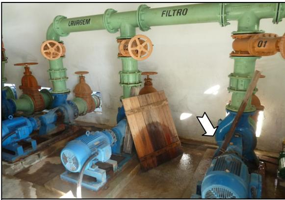
**Foto 35 e 36** – EELF-01: vazamento no conjunto motor-bomba 1.
