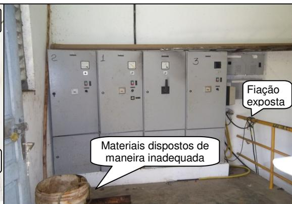
**Foto 6** – EEAB-01: fiação exposta e materiais dispostos de maneira inadequada.
