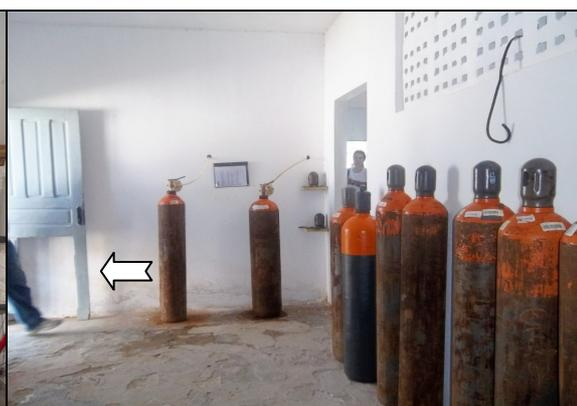
**Foto 28** – Sala de dosagem e estocagem dos cilindros de cloro apresentando porta danificada.
