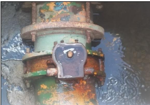
**Foto 21** – Filtro 5: tubulação de entrada apresentando vazamento .
