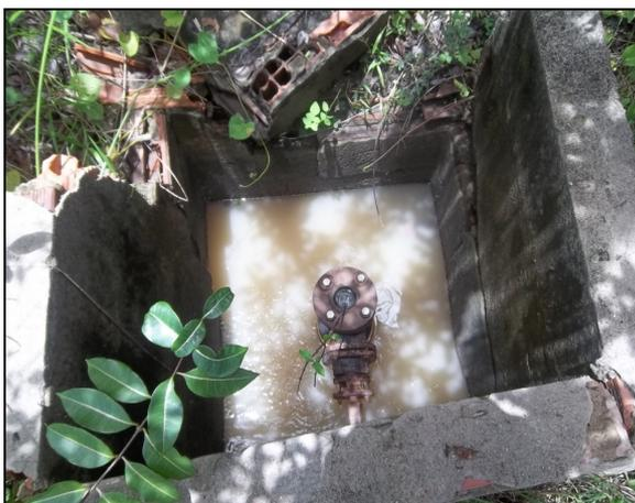
**Foto 67** – Ventosa na adutora de água bruta apresentando vazamento, e caixa danificada e sem tampa.
