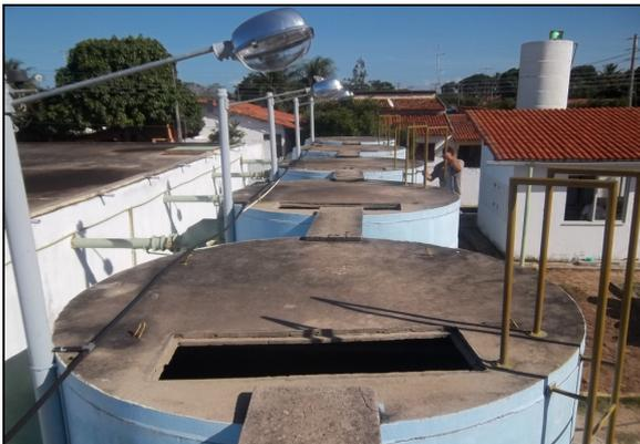
**Foto 23** – Filtros apresentando aberturas de inspeção sem tampas.
