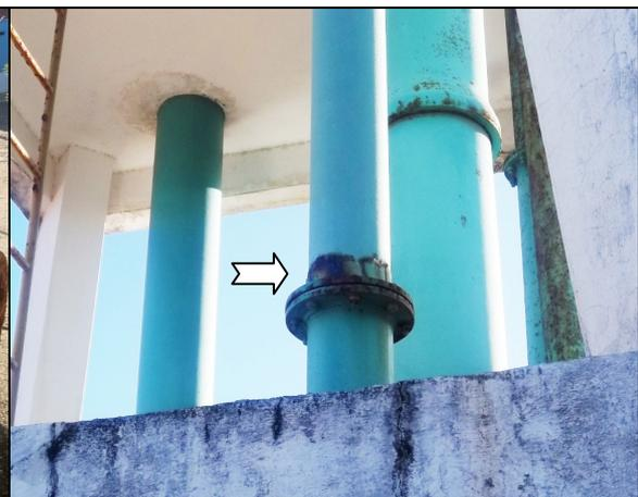
**Fotos 51 e 52** – REL-01: tubulações em estado avançado de corrosão.
