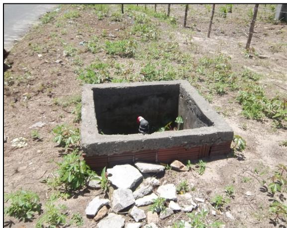
**Foto 69** – Caixa de inspeção sem tampa de ventosa na adutora de água bruta.
