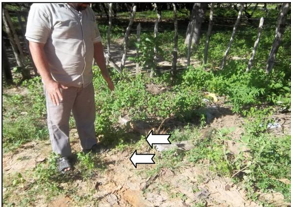
**Foto 74** – Registro de descarga soterrada e sem caixa de inspeção na Rua Pedro Facundo.
