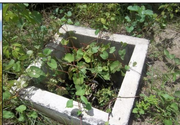
**Foto 4** – Caixa de inspeção sem tampa e tomada pela vegetação na área da captação.
