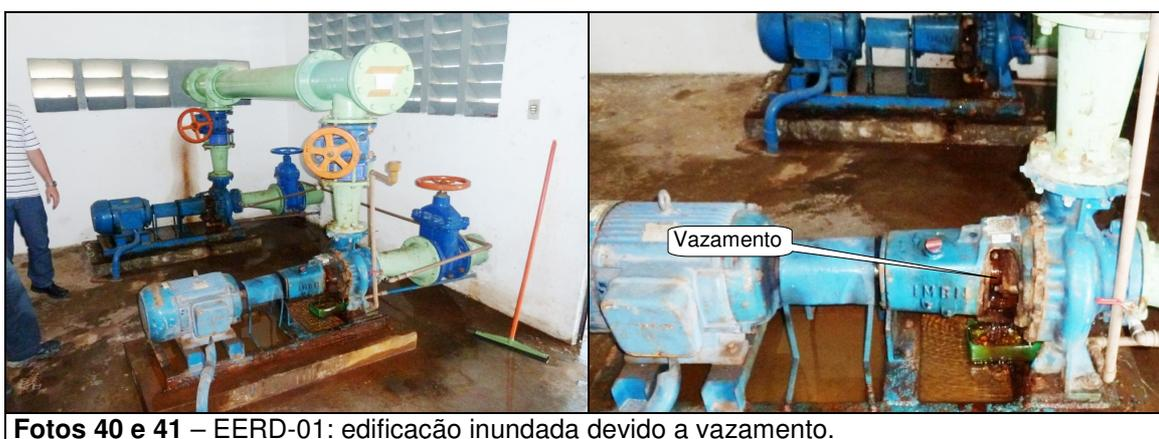
Fotos 40 e 41 – EERD-01: edificação inundada devido a vazamento.
