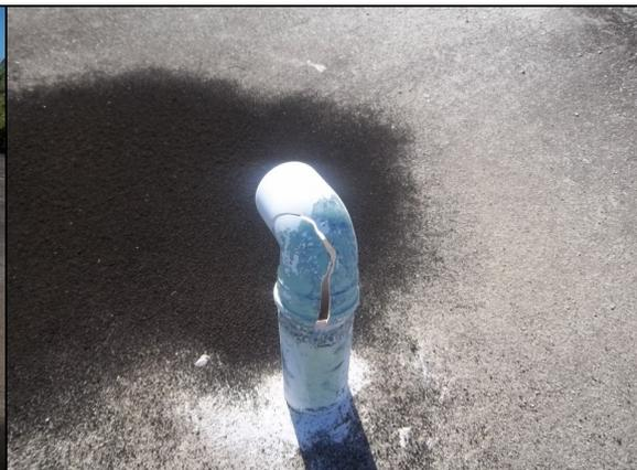
**Foto 43** – RAP-01: tubulação de ventilação danificada.
