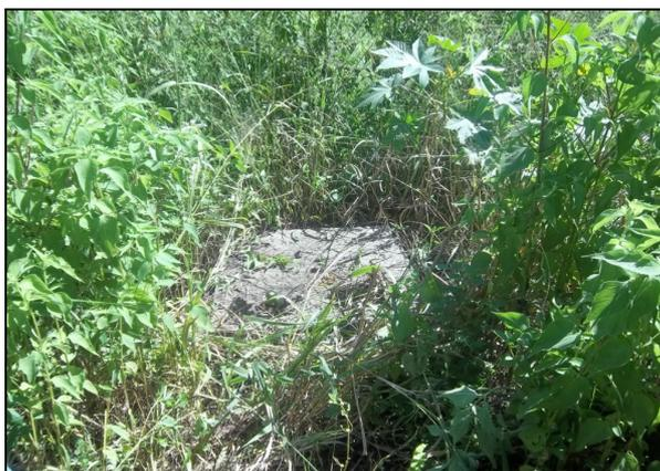
**Foto 72** – Caixa de inspeção de registro de descarga na Rodovia CE-040 – Matadouro: tomada pela vegetação.
