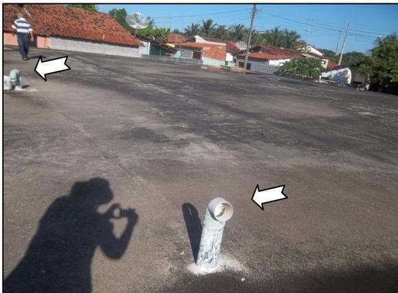
**Foto 42** – RAP-01: tubulações de ventilação inadequadas.
