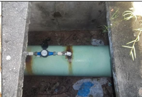
**Fotos 11 e 12** – Caixas de inspeção de macromedidores sem tampa ou grade na área da ETA.
