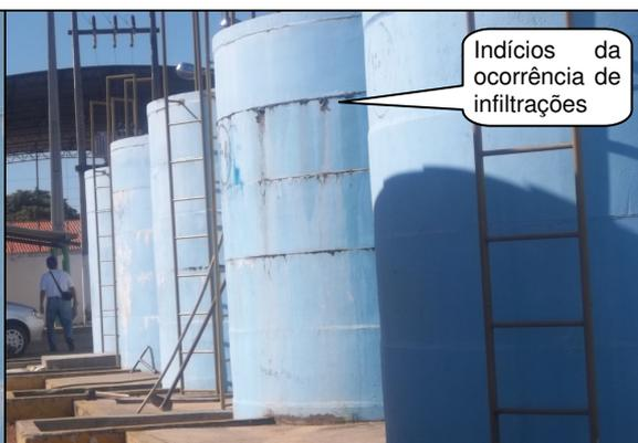
**Foto 16** – Filtros do SAA de Cascavel: indícios da ocorrência de infiltrações e vazamentos.
