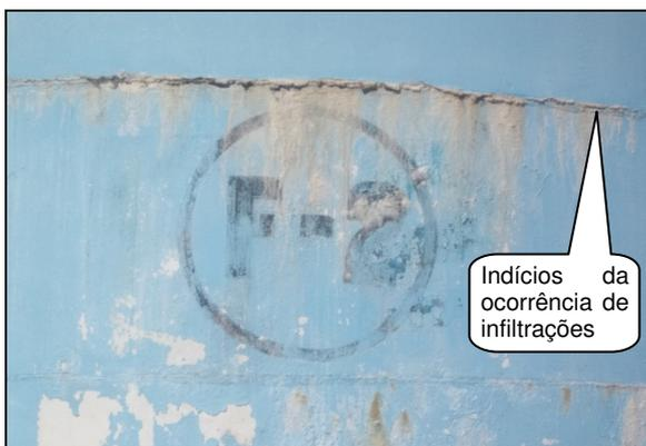
**Foto 15** – Filtro 2: indícios da ocorrência de infiltrações e vazamentos, e pintura e sinalização de identificação deterioradas.
