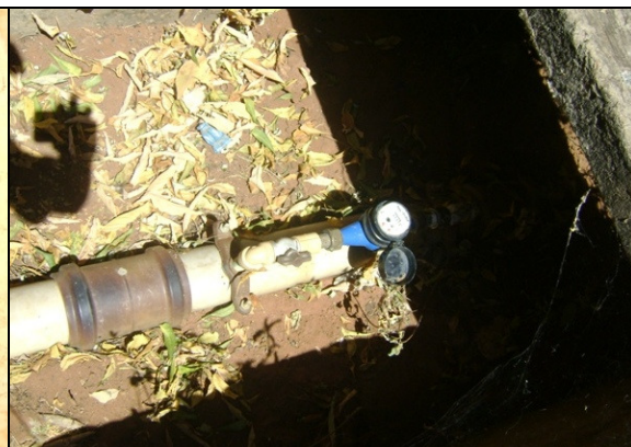
Foto 52 – Caixa do medidor proporcional de água tratada na saída do PT-05.
