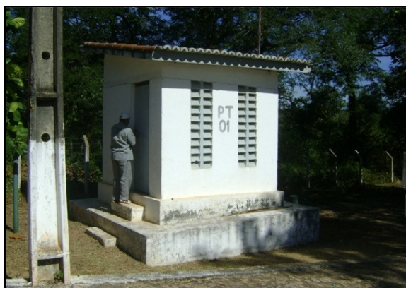
Foto 3 – Prédio de abrigo do quadro de comando da EEPT-01.
