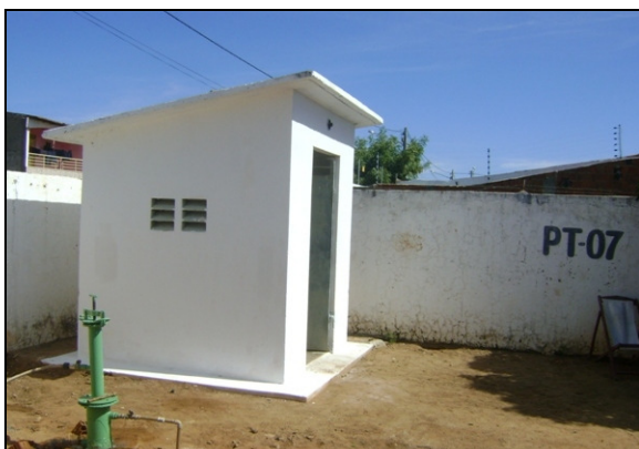
Foto 20 – Prédio de abrigo do quadro de comando da EEPT-07.
