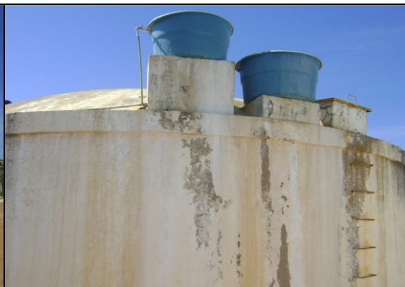
Foto 34 – Inspeção, escada de acesso e dosador de hypocal do RAP-01.
