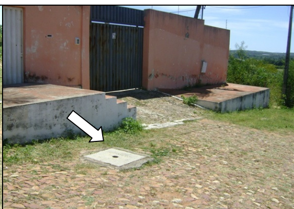
Foto 62 – Registro de descarga localizado na Rua Madre Ilduária, Alto da Alegria.
