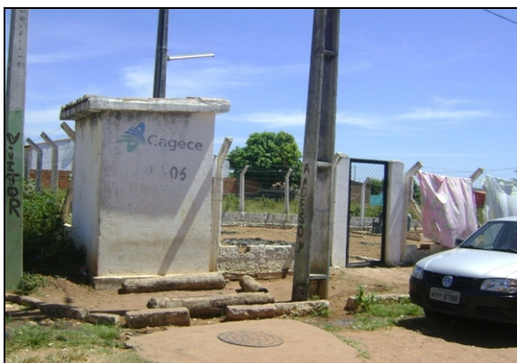
Foto 16 – Prédio de abrigo do quadro de comando da EEPT-06.
