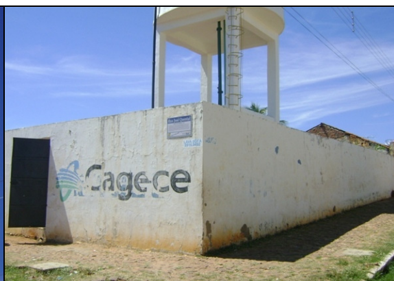
Foto 38 – Muro de proteção do REL-01.
