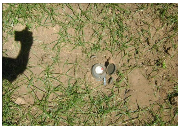
Foto 55 – Macromedidor de água tratada, sem caixa de proteção, na saída do PT-09.
