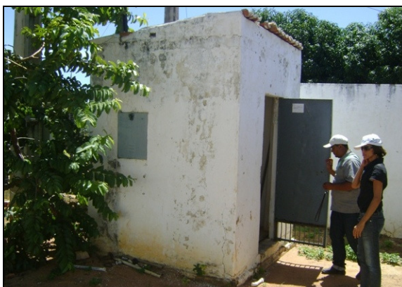
Foto 13 – Prédio de abrigo do quadro de comando da EEPT-05.
