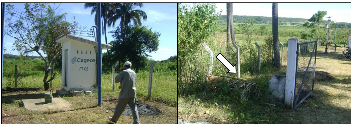
Foto 6 – Prédio de abrigo do quadro de comando da EEPT-02.
