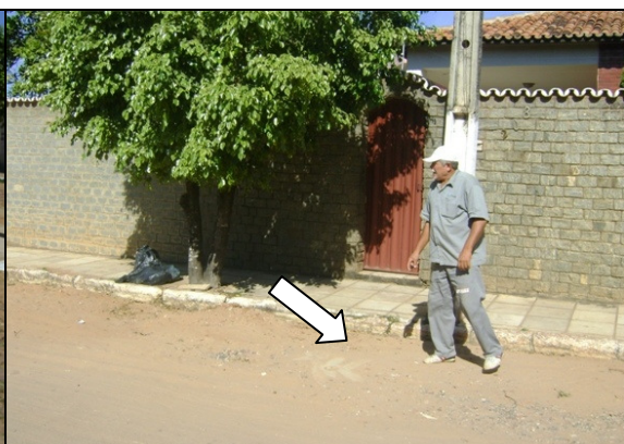
Foto 58 – Registro de descarga soterrado, localizado na Rua Zuca Sampaio, Rosário.
