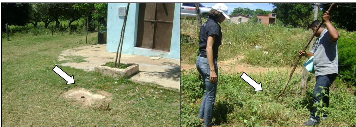
Foto 64 – Registro de descarga sem caixa de proteção, localizado na Av. José Bernardino, Malvinas.
