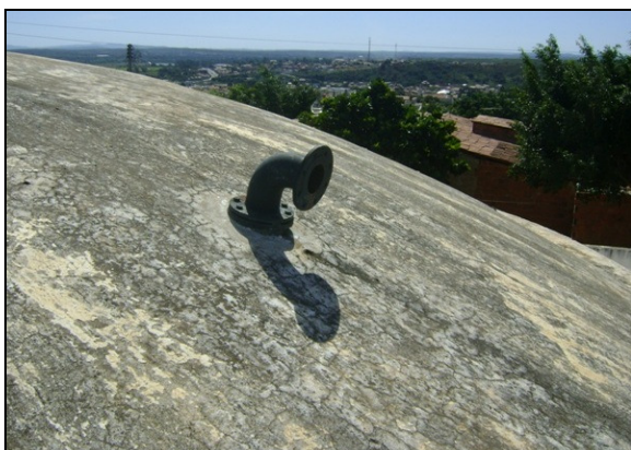
Fotos 35 e 36 – Ventilações do RAP-01, sem tela de proteção.
