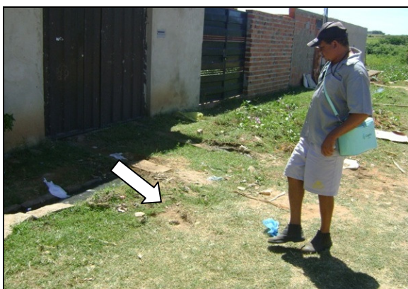
Foto 61 – Registro de descarga sem caixa de proteção, localizado na Rua Anderson Sabino, Alto da Alegria.
