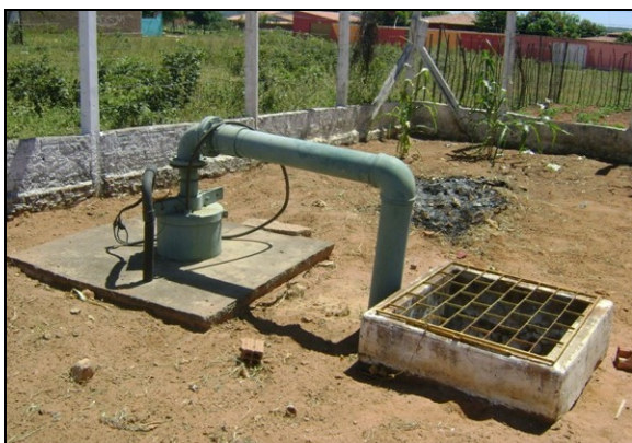
Foto 14 – Poço tubular PT-06.
