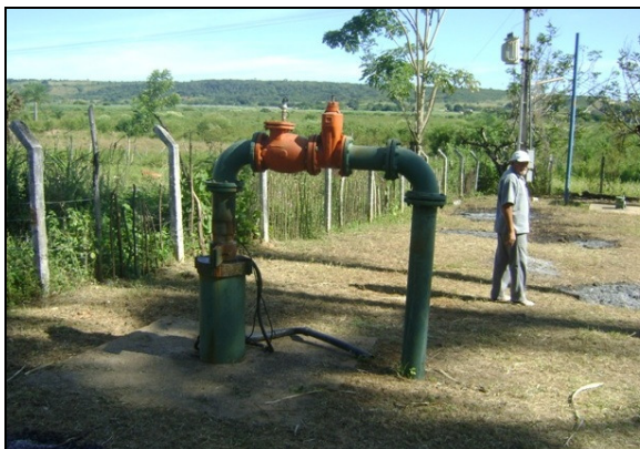
Foto 4 – Poço tubular PT-02.
