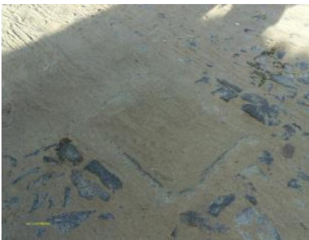
Foto 31 – Rede de distribuição: registro de descarga na Rua João Correia Dodó
