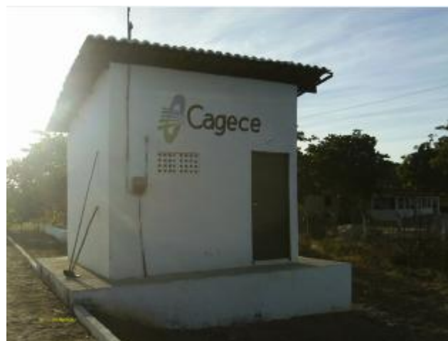
Foto 44 – Edificação de apoio aos operadores.
