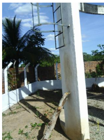
Foto 20 – REL-06: escada de acesso.
