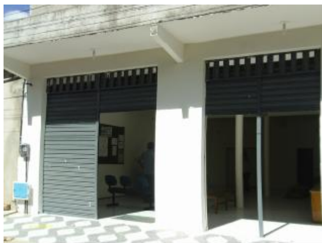
Foto 58 – Loja de atendimento: vista externa.
