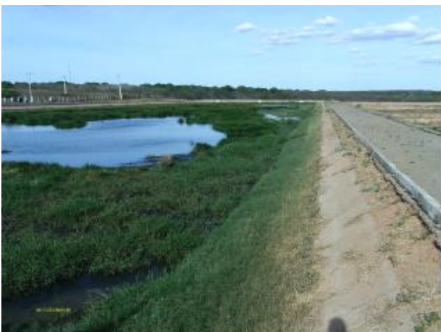
Foto 51 – Lagoa facultativa: presença de vegetação.
