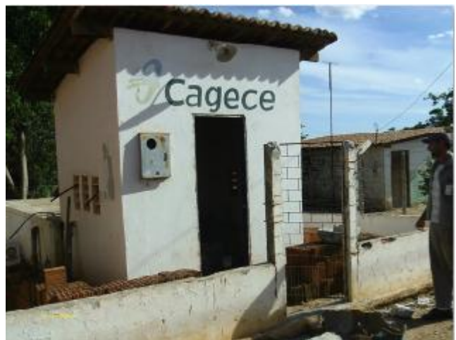
Foto 4 – EEAT-06 Booster : ausência de identificação e de cerca na casa de abrigo do conjunto moto-bomba.
