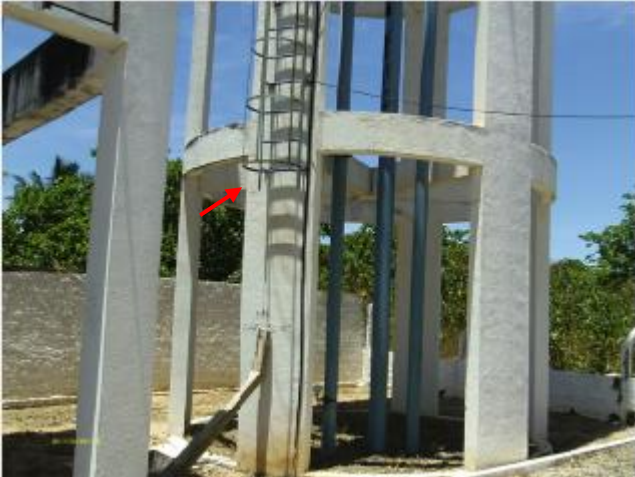
Foto 9 – REL-04: escada de acesso.
