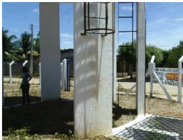
Foto 16 – REL-05: escada de acesso.
