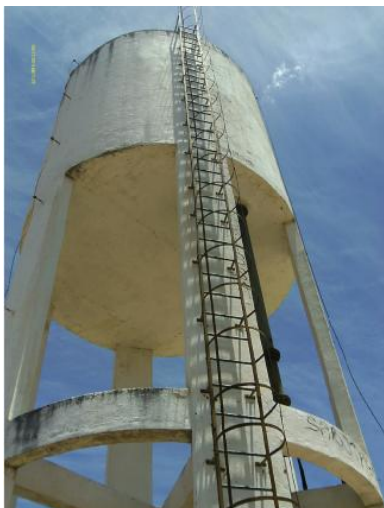
Foto 15 – REL-05: escada com guarda corpo.
