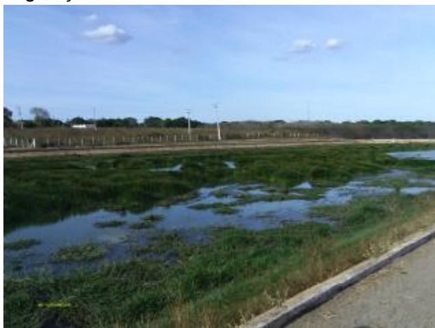
Foto 52 – Lagoa facultativa: presença de vegetação.
