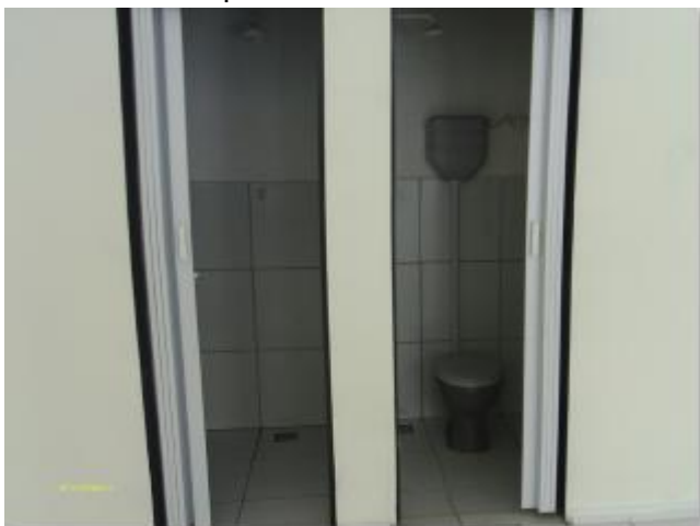
Foto 62 – Loja de atendimento: instalações sanitárias.
