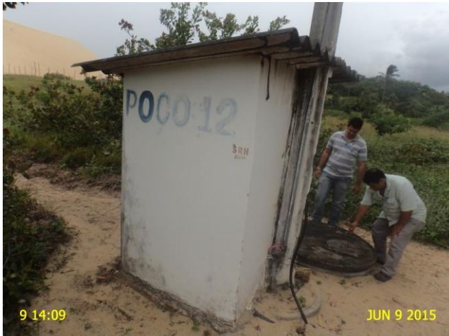
Foto 1 - PT-12: sem iluminação e identificação pouco visível.
