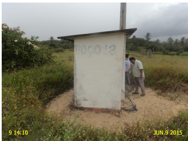
Foto 5 - PT-13: identificação pouco visível.
