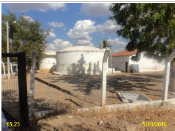
Foto 3 – ETA (Sucesso): ausência de identificação.
