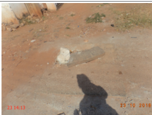
Foto 15 - RDA: existe uma caixa de inspeção com a tampa quebrada em frente a ETA.
