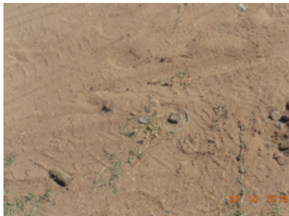
Foto 5 - RDA: Registro de descarga localizado no endereço: Avenida Francisco Ferreira da Cunha está sem proteção.
