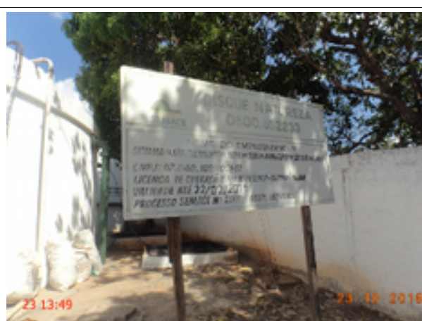
Foto 25 - ETA: Placa da SEMACE está com a validade vencida desde de 22/02/2014.
