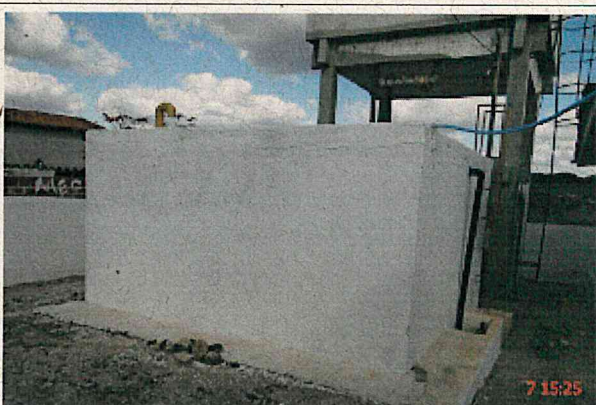
Foto 27 – RAP-02: ausência de identificação.
