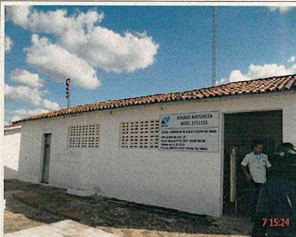
Foto 32 – ETA: identificação pouco visível.
