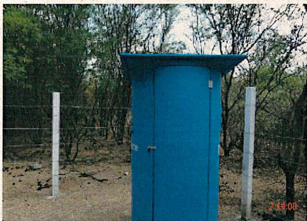
Foto 18 – PT-14: ausência de identificação.
