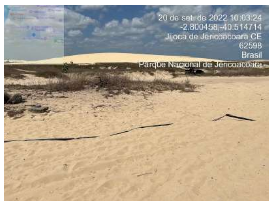
Foto 11 - Poços (Jericoacoara): fiação aparente na área dos poços.
