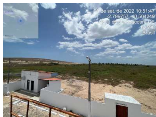
Foto 24 - ETE (Jericoacoara): infraestrutura operando acima da capacidade operacional.
