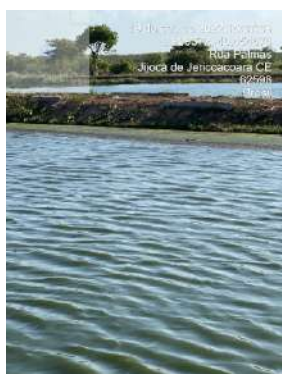
Foto 21 - ETE (Jijoca): ausência de placas de proteção em todos os taludes das Lagoas de Maturação.
