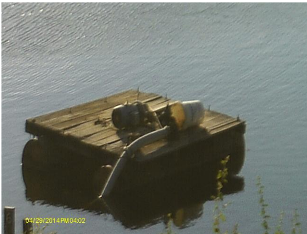
Foto 3 – Bomba da captação.
