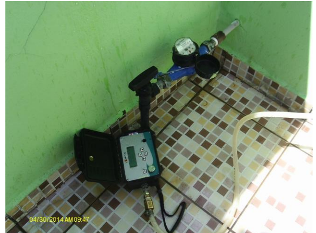
Foto 84 – Medição de pressão na Rua São Raimundo Nonato, nº 30 – Centro.
