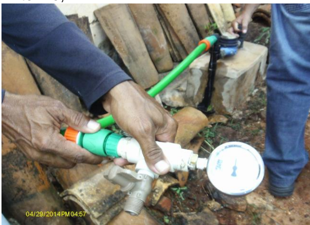
Foto 81 – Medição de pressão na Rua Guilhermina Rodrigues (Alagoinha), s/n.
