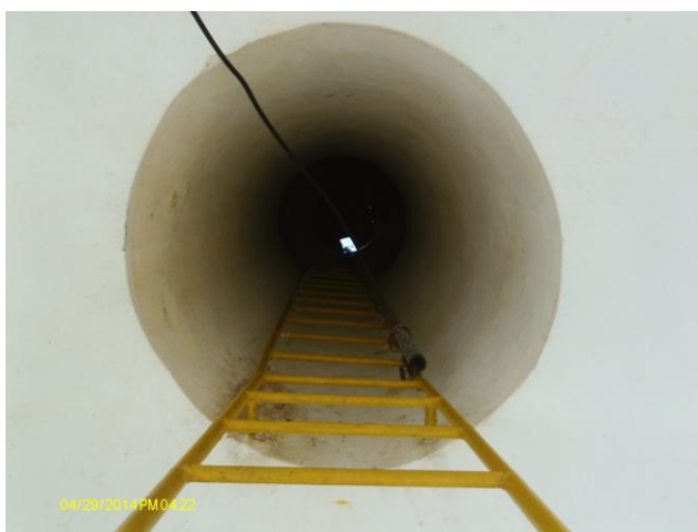
Foto 69 – REL-01: tampa de inspeção.
