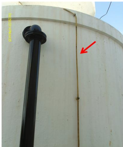
Foto 55 – RAP-01: medidor de nível e descarga.
