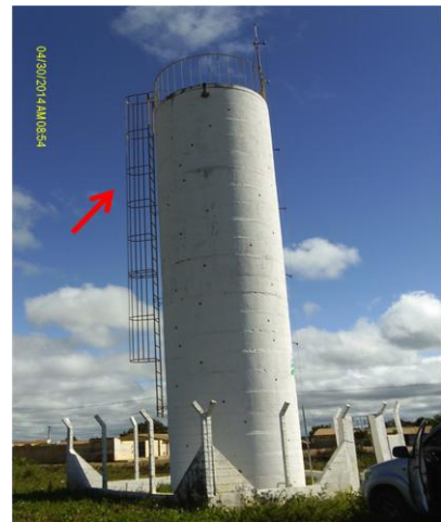
Foto 74 – REL-03: escada de acesso.
