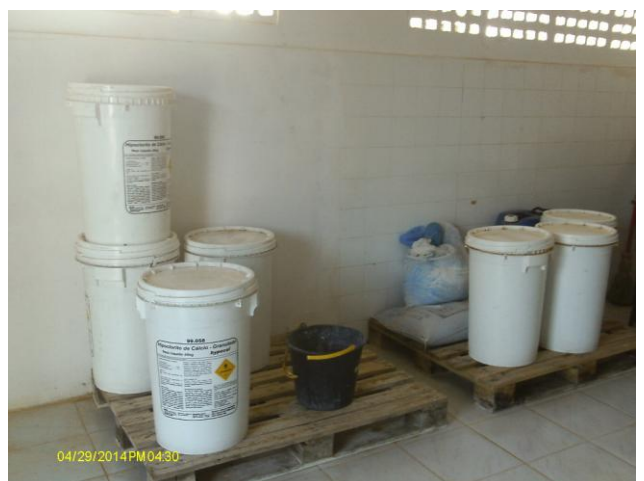
Foto 18 – Casa de química: almoxarifado de produtos químicos.
