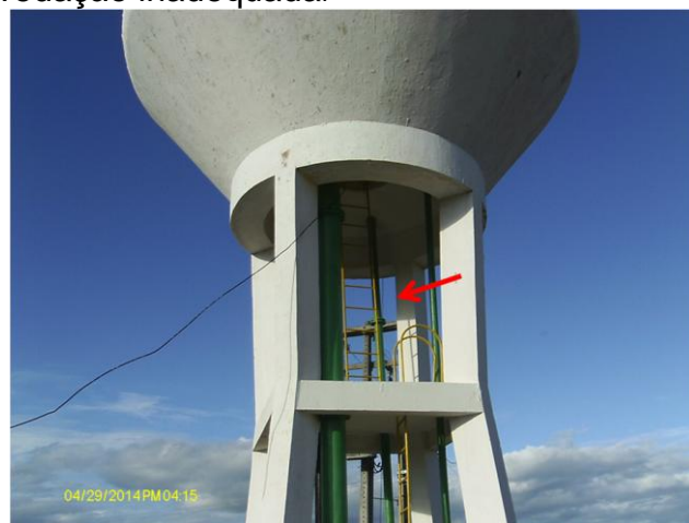
Foto 68 – RSE-01: escada de acesso.
