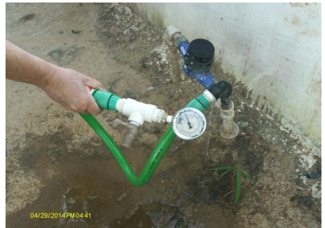
Foto 80 – Medição de pressão Rua Manoel Lina (Alagoinha), s/n.
