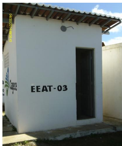
Foto 41 – Casa de abrigo da EEAT-03.
