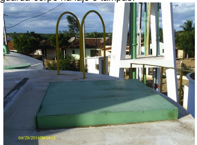
Foto 12 – Filtro-01: vedação de tampa adequada.
