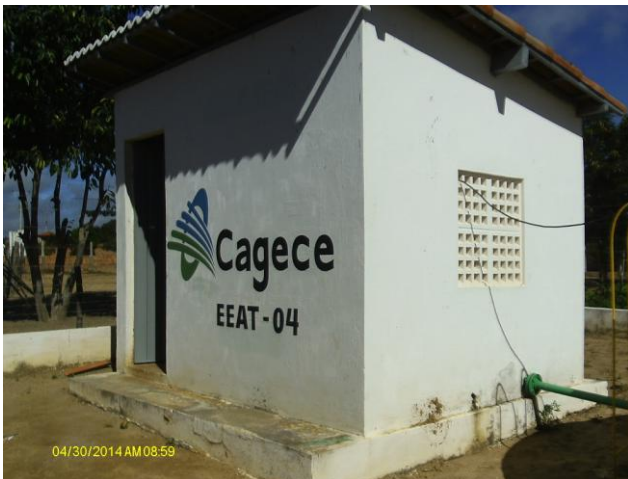
Foto 50 – Casa de abrigo da EEAT-07 com identificação errada.
