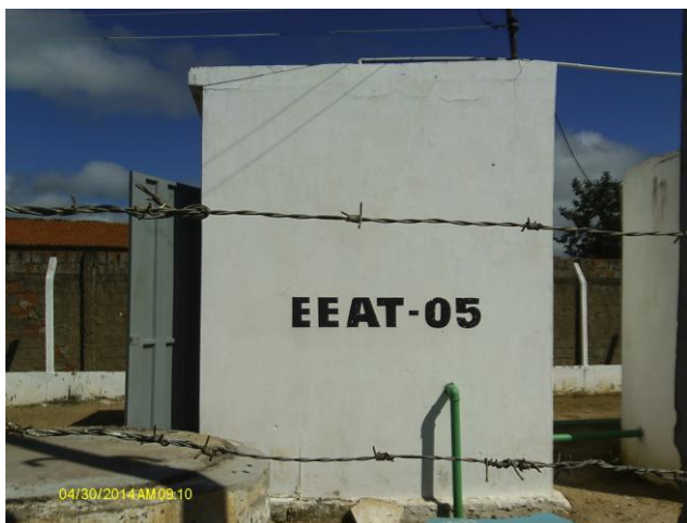
Foto 44 – Casa de abrigo da EEAT-05.
