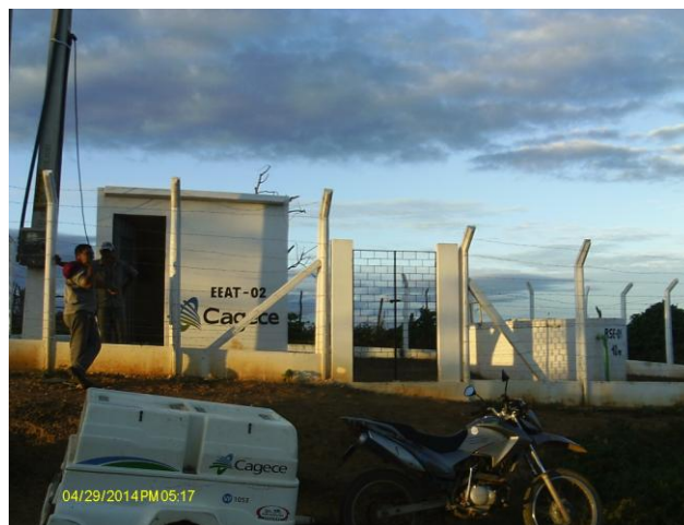
Foto 47 – Casa de abrigo da EEAT-06 com identificação errada.
