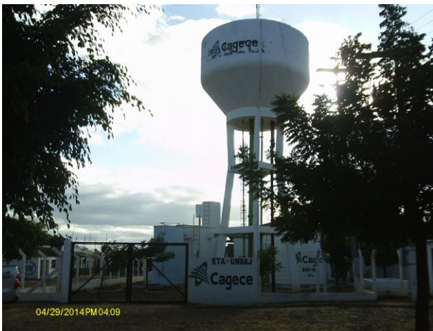
Foto 7 – Vista externa da ETA.
