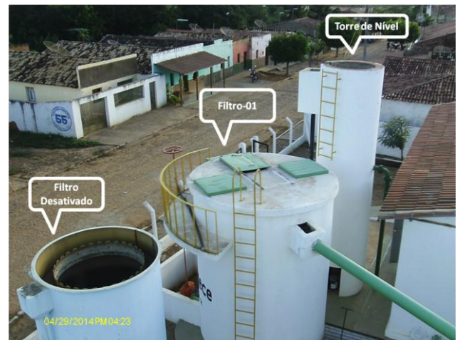
Foto 10 – Filtro-01: com escada de acesso, guarda-corpo na laje e tampas.
