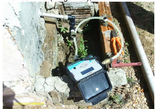
Foto 82 – Medição de pressão na Rua Rua Sipaubá, nº 01 - Centro.
