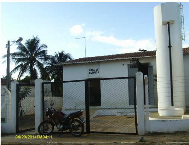
Foto 15 – Vista externa da casa de química e bombas.
