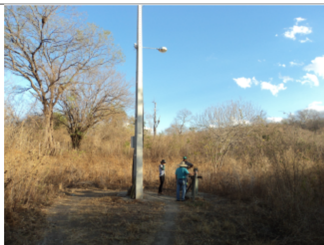
Foto 28 – PT-02: ausência de identificação.
