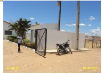
Foto 18 – ETA: ausência de identificação.
