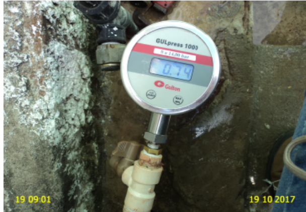
Foto 4 – RDA: medição de pressão instantânea na Rua Monsenhor Tavares, nº 325 (7,4 mca).
