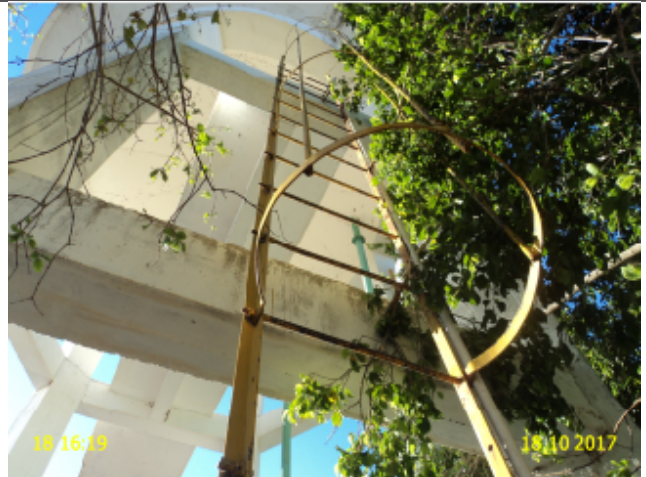
Foto 16 – REL-01: escada em processo de corrosão.
