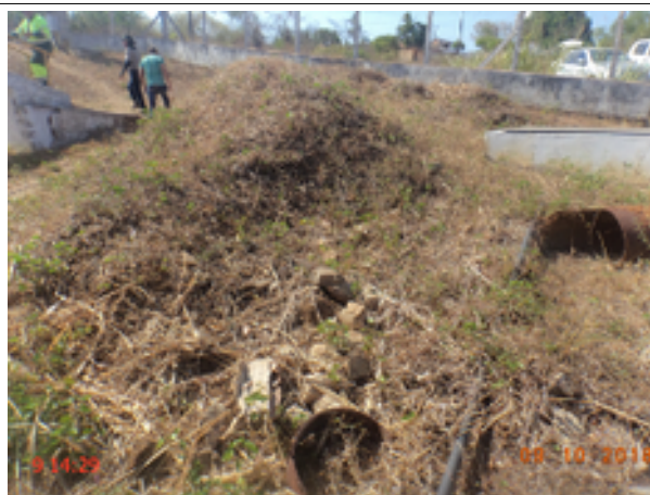
Foto 7 - ETA (Sede): Pátio externo com Vegetação excessiva.
