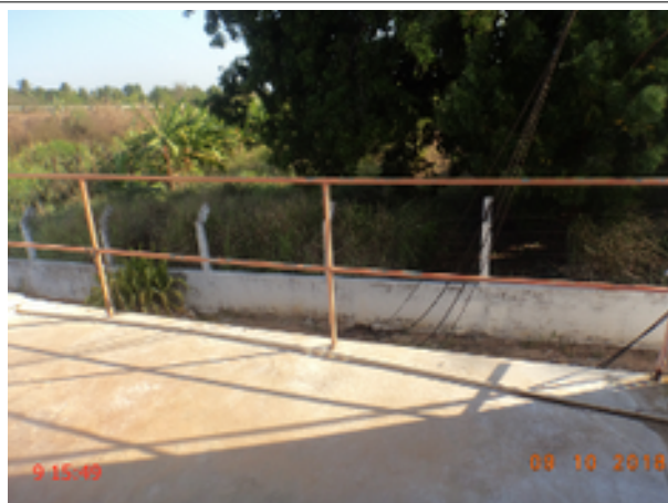
Foto 21 - Reservatório (Sebastião de Abreu): RSE-01 não está identificado.
