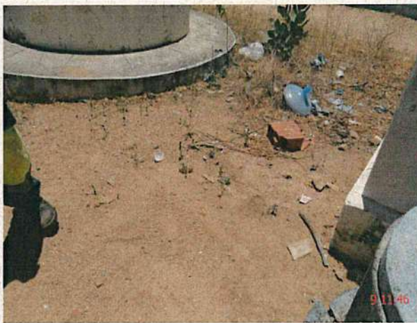
Foto 26 – RDA (Lisieux): registro de descarga soterrado na Rua Antônio Vasconcelos de Araújo.
