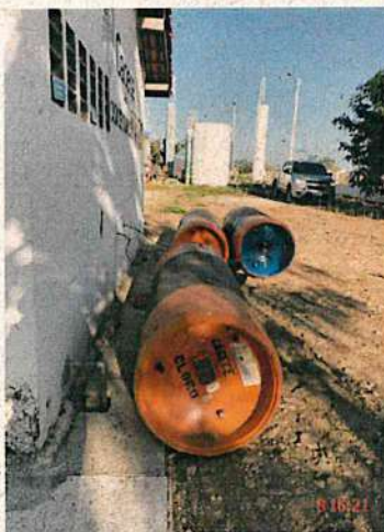
Foto 7 – Casa de química (Sede): cilindros de cloro gasoso sob a influência direta de luz solar.
