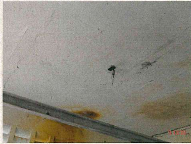
Foto 46 – EEAB-01 (Lisieux): ausência de iluminação.
