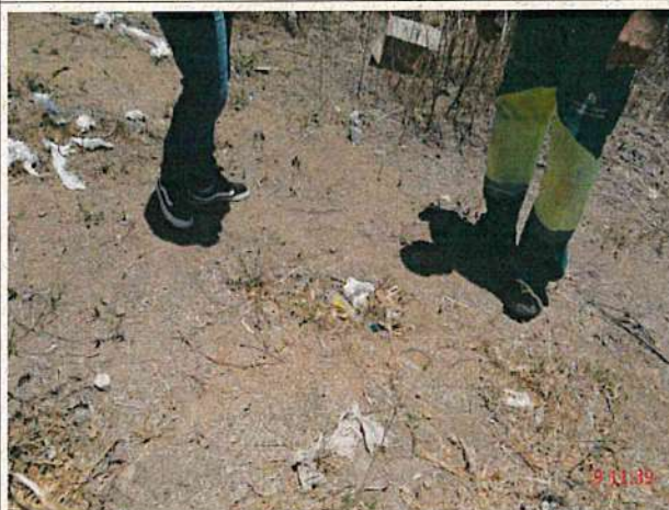
Foto 25 – RDA (Lisieux): registro de descarga soterrado na Rua Antônio Maurício Lira Alves.
