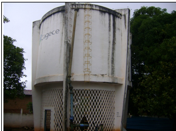
Foto 44 – Vista do REL-01.
