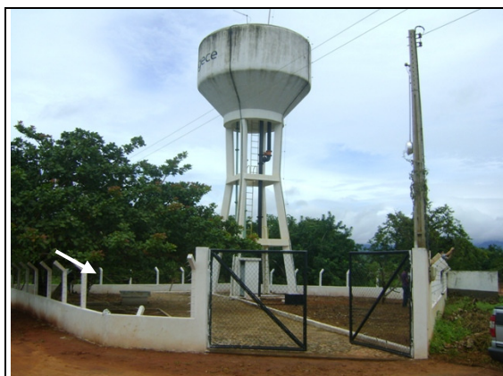
Foto 48 – Vista do REL-02
