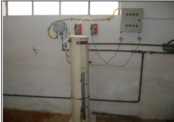
Foto 16 – Sistema de fluoretação.
