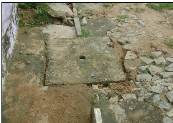
Foto 54 – Registro de descarga localizada no Conjunto Novo Planalto IV.
