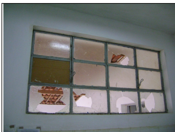
Foto 10 – Vista do laboratório da ETA.
