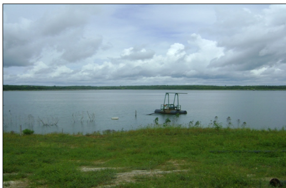
Foto 1 – Vista da captação.
