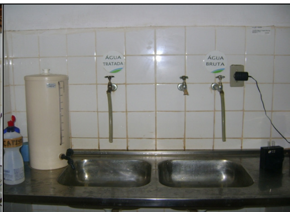
Foto 9 – Vista do laboratório da ETA.
