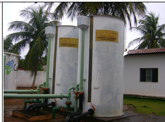
Foto 6 – ETA: Filtros apresentando bom estado de conservação.
