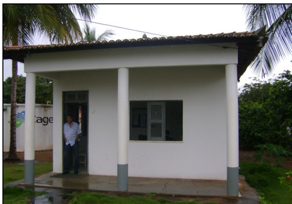
Foto 58 – Vista externa do escritório/loja de atendimento ao usuário.
