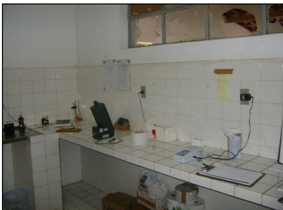
Foto 8 – Vista do laboratório da ETA.
