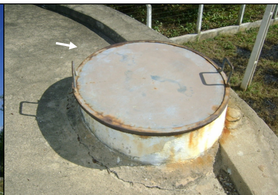
Foto 36 – RAP-02: Tapa de inspeção adequada.
