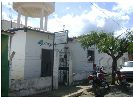
Foto 47 – Vista externa do escritório/loja de atendimento ao usuário.
