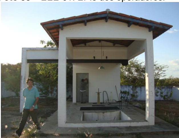
Foto 90 – EEE-02: vista interna.
