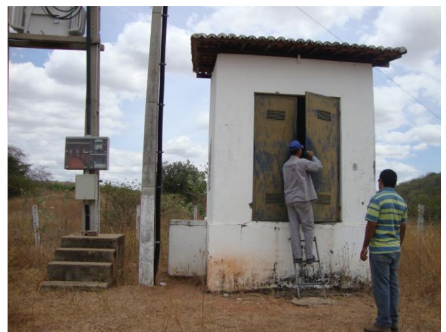
Foto 6 – Casa de abrigo do quadro de comando da captação subterrânea.
