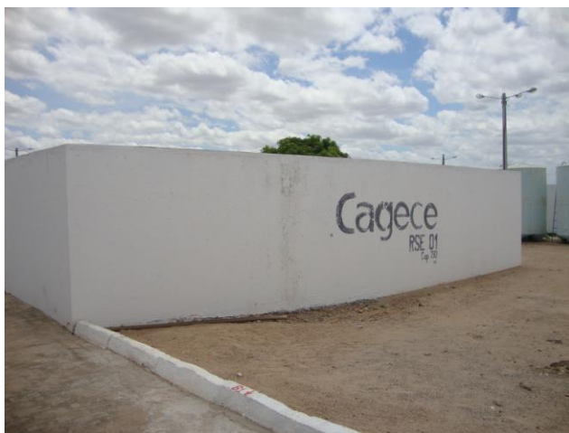
Foto 43 – Vista do RSE-01 de água bruta.
