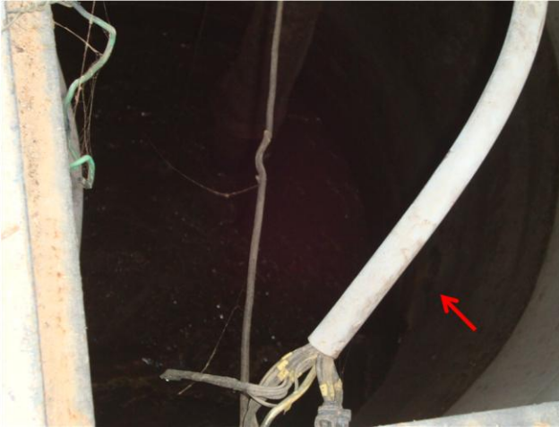
Foto 82 – EEE-01: poço de visita de chegada.
