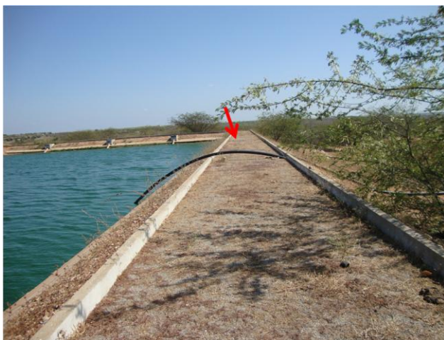
Foto 108 – Adaptação provisória para a saída do esgoto tratado da lagoa de maturação 02 para o corpo receptor.
