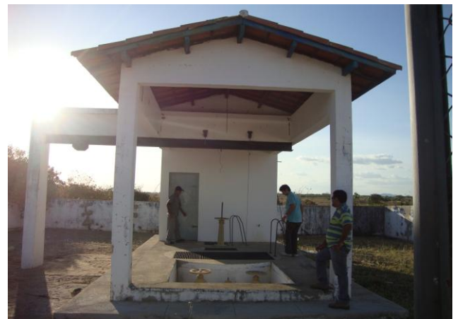
Foto 81 – EEE-01: poço de gradeamento e poço de sucção de chegada.
