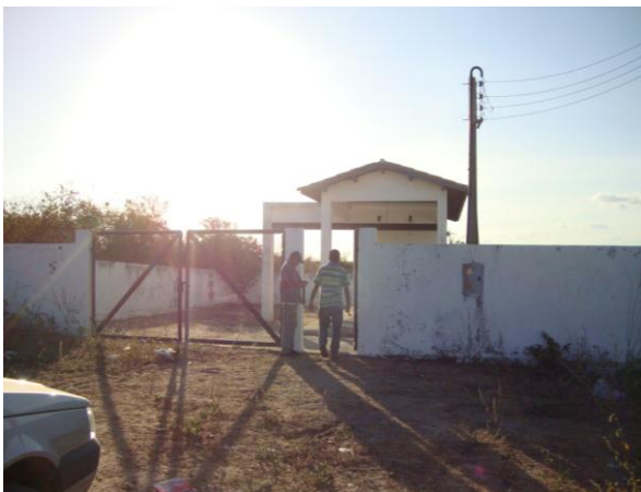
Foto 80 – EEE-01: vista da externa.
