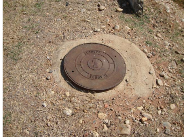
Foto 130 – ETE: poço de saída da lagoa de maturação 02 desativado.
