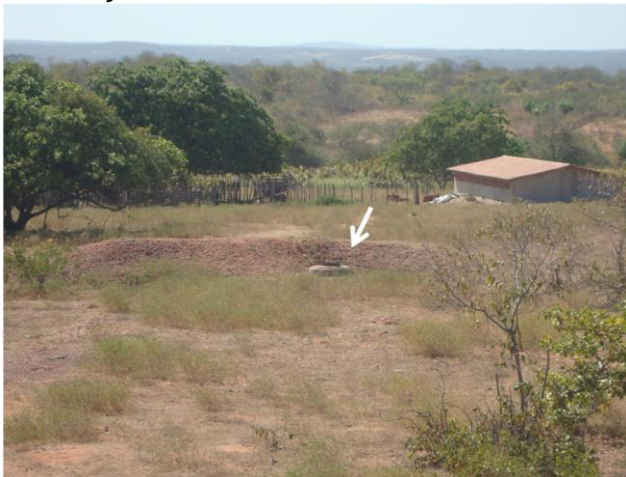
Foto 131 – ETE: poço de saída da lagoa de maturação 02 desativado.
