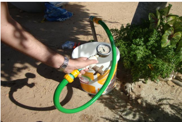
Foto 63 – Medição de pressão na Rua Anísio Mendes Barreto, s/n – Centro.
