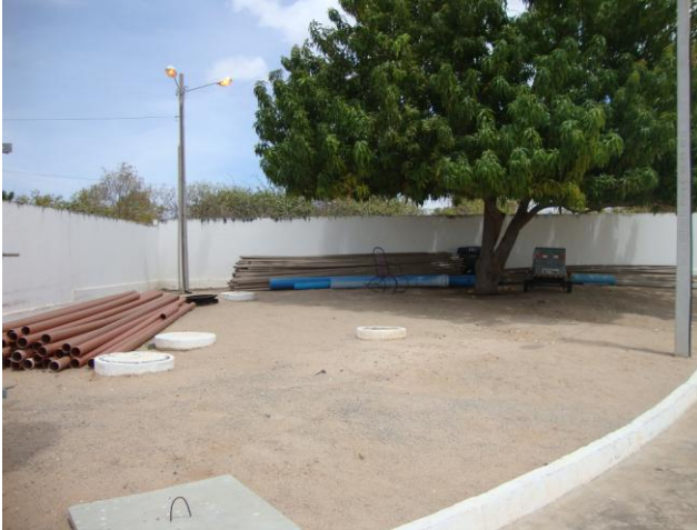
Foto 30 – Tubulação armazenada de forma inadequada, na área da ETA.
