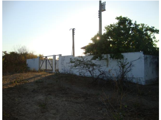
Foto 89 – EEE-02: vista da externa.
