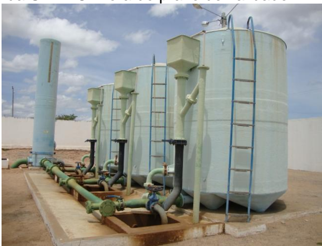
Foto 10 – Vista dos filtros 01, 02 e 03 de fluxo ascendente.
