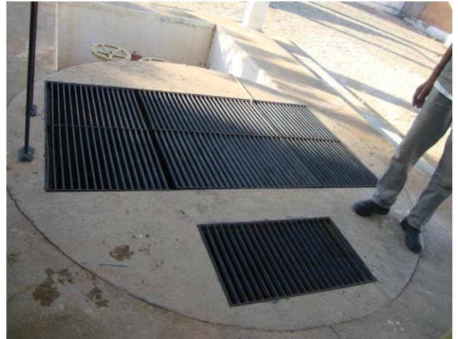
Foto 101 – EEE-03: poço de gradeamento e poço de sucção de chegada.
