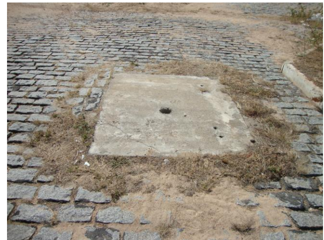
Foto 70 – Registro de descarga na Av. Melania Bezerra.
