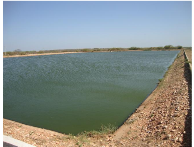
Foto 118 – ETE: vista da lagoa facultativa.
