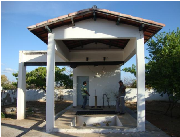
Foto 100 – EEE-03: vista da interna.
