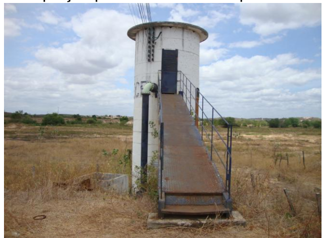
Foto 4 – Vista externa do Poço Amazonas.
