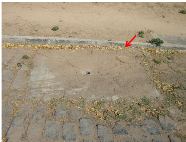
Foto 75 – Registro de descarga na Rua Zé Parente.
