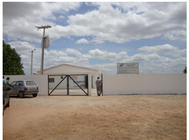
Foto 9 – Vista externa da ETA.
