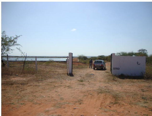
Foto 111 – Vista externa da ETE.
