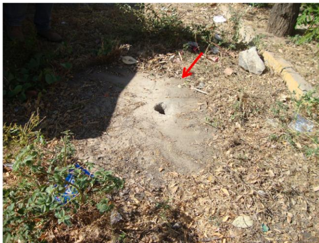
Foto 73 – Registro de descarga na Av. Possino Maia.
