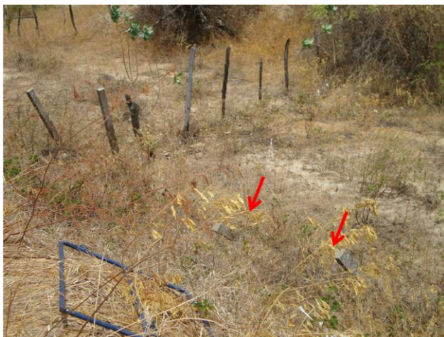
Foto 3 – Trechos da cerca danificada.
