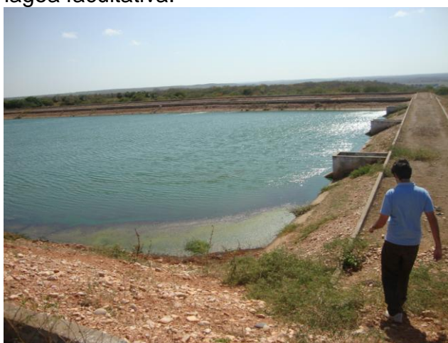
Foto 121 – ETE: vista da lagoa de maturação 01.
