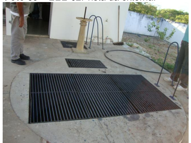
Foto 91 – EEE-02: poço de gradeamento e poço de sucção de chegada.
