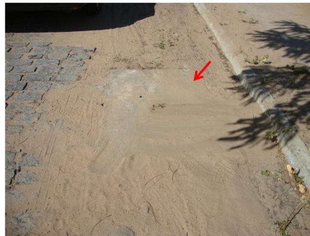
Foto 74 – Registro de descarga na Rua José Martins Gonçalves.
