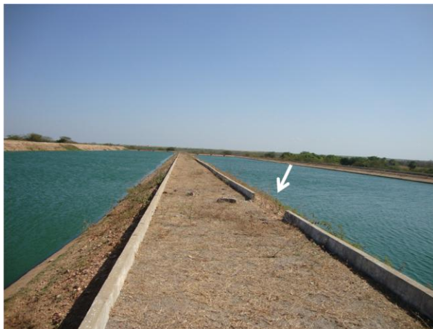
Foto 123 – ETE: vista das lagoas de maturação 01 e 02, respectivamente.
