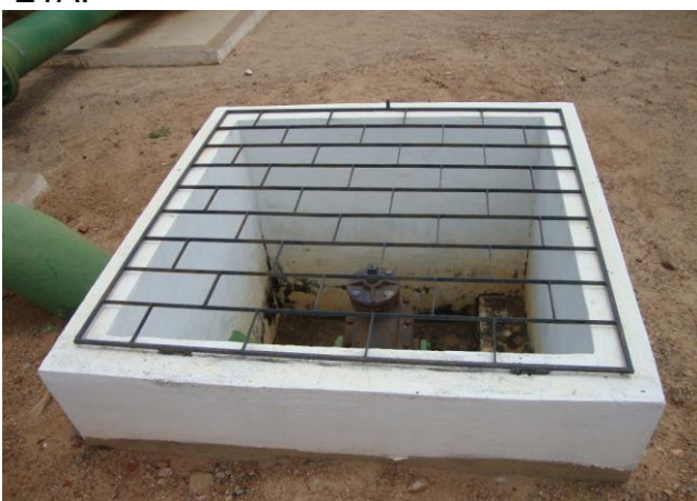
Foto 33 – Caixa de inspeção do registro de água bruta próximo aos filtros.
