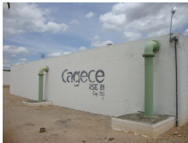
Foto 44 – Vista do RSE-01 de água bruta.
