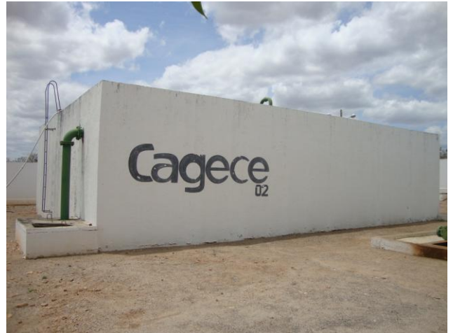
Foto 48 – Vista do RSE-02 de água tratada.
