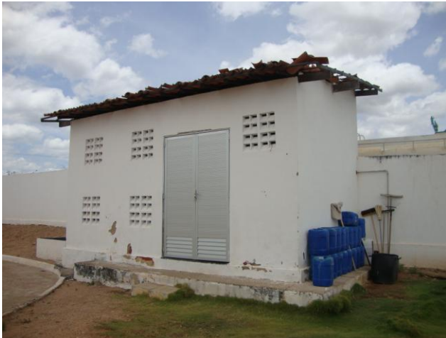
Foto 18 – Vista externa do almoxarifado de materiais e produtos químico.
