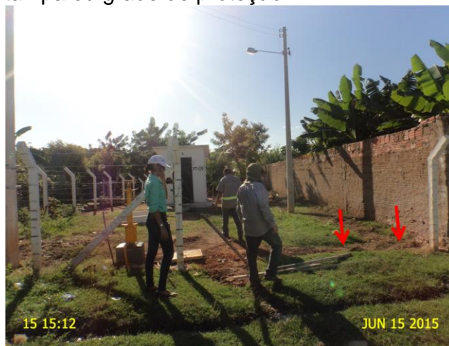
Foto 11 – PT-09: cerca inadequada.
