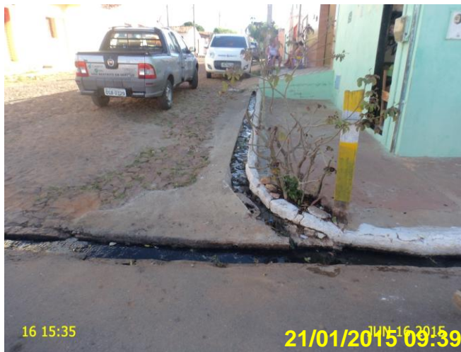
Foto 35 - Lançamento de esgoto a céu aberto no endereço Rua Airton Landim de Araújo.
