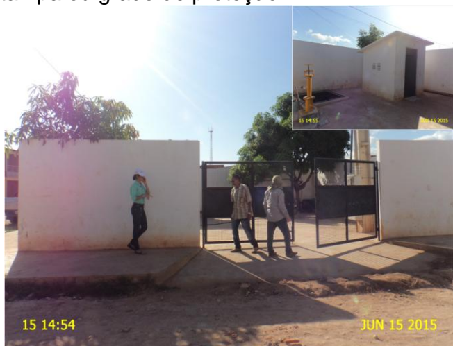
Foto 10 – PT-07: ausência de identificação.
