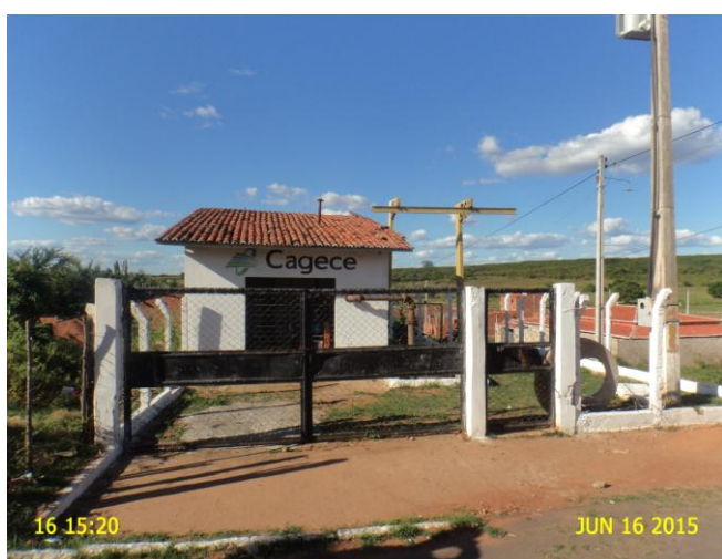
Foto 16 – EEE-03: ausência de identificação.
