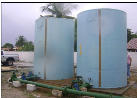
Foto 4 – Vista dos filtros.
