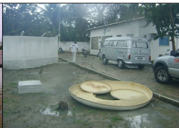
Foto 5 – Tampa dos filtros.
