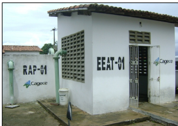
Foto 23 – Prédio de abrigo da elevatória EEAT-01.
