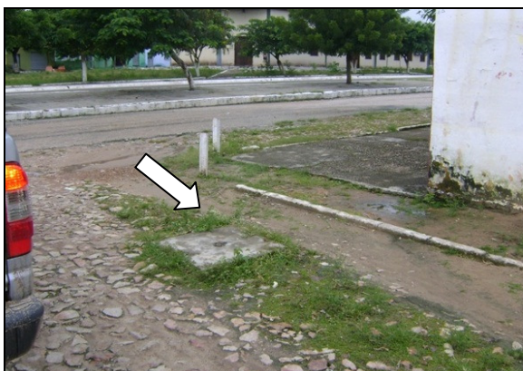
Foto 44 – Registro de descarga localizado na Rua José Cunha, Centro.
