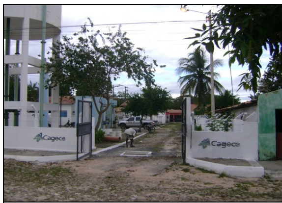
Foto 3 – Entrada da ETA.
