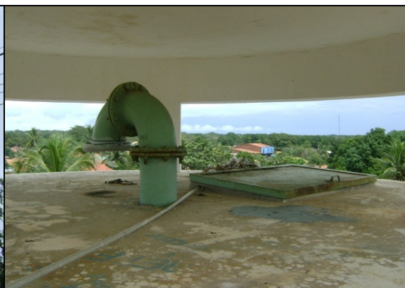
Foto 25 – Inspeção e ventilação do reservatório de quebra de pressão.
