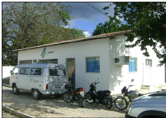
Foto 46 – Vista externa do escritório da CAGECE.
