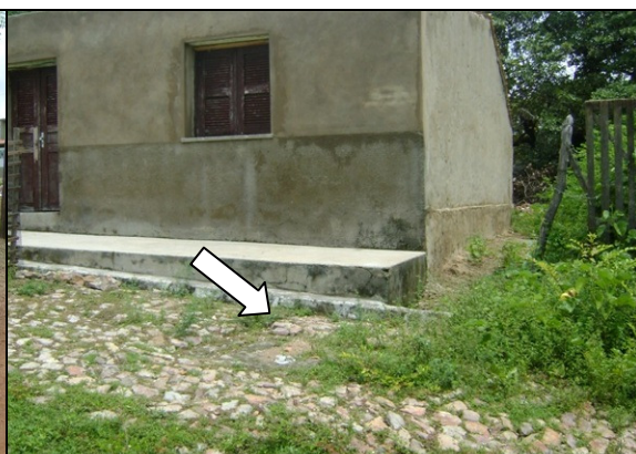
Foto 43 – Registro de descarga, localizado na Estrada para Sobral.
