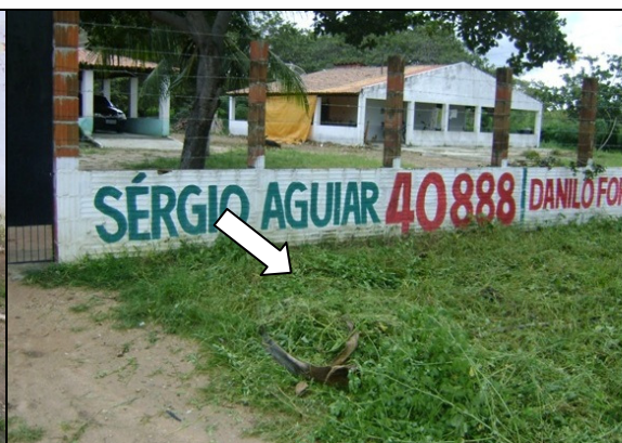
Foto 45 – Registro de descarga soterrado, localizado na Av. Presidente Castelo Branco, Centro.
