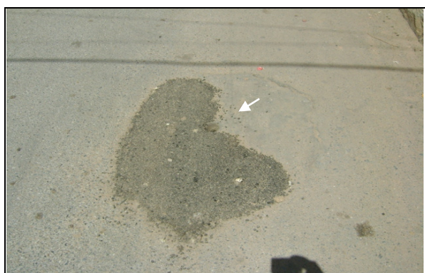
Foto 52 – Registro de manobra localizado na Rua Serafim Aquino.
