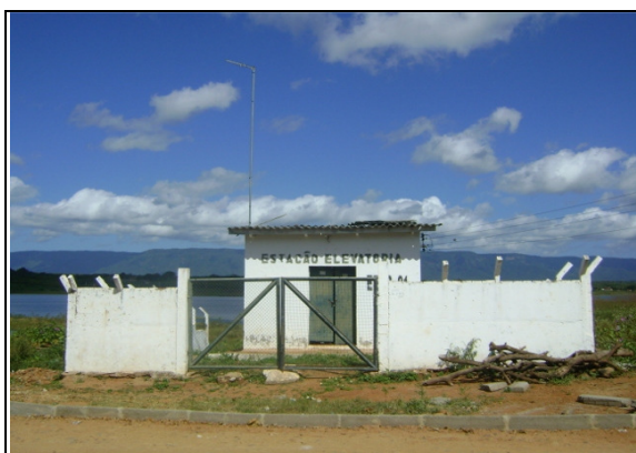
Foto 23 – EECS-01: Vista externa.
