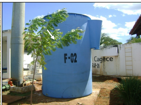
Foto 7 – Filtro 02: A ser instalado.
