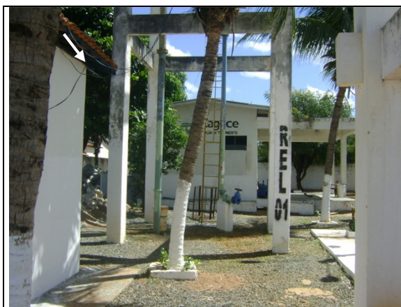
Foto 42 – REL-01: Existência de identificação.
