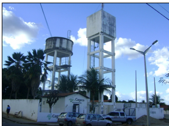
Foto 3 – Vista da ETA.
