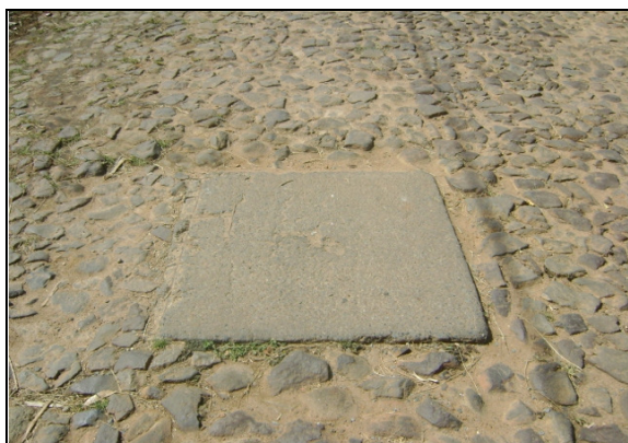
Foto 22 – Adutora de água bruta: Ventosa.
