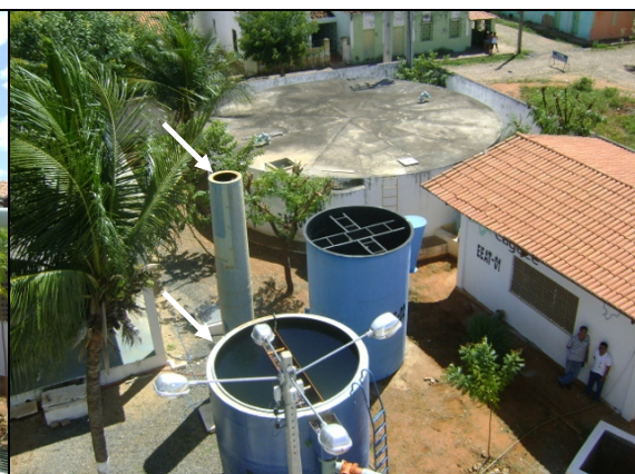
Foto 5 – Filtro 01: Sem tampa de proteção na torre de nível e no filtro.
