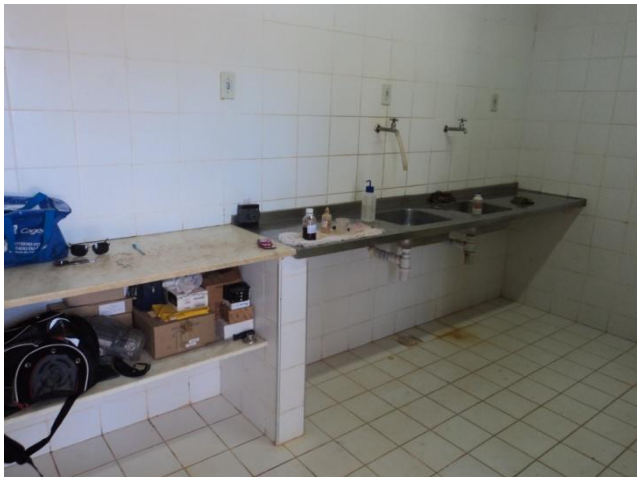
Foto 28 – Laboratório: vista geral-condições de limpeza e organização adequadas.
