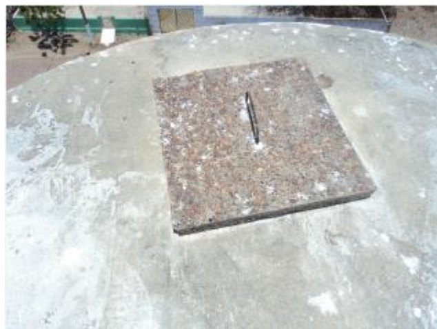
Foto 71 – REL-02: tampa de inspeção adequada.
