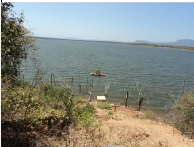
Foto 3 – Açude Itaúna: vista geral da captação.
