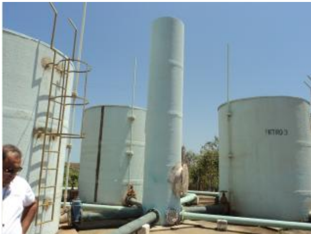
Foto 10 – ETA: torre de nível.
