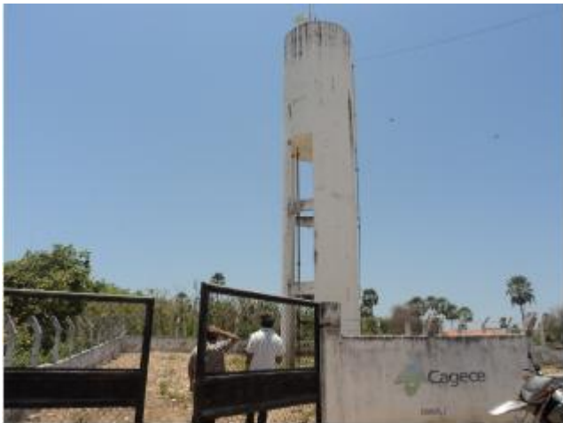
Foto 68 – REL-02: vista geral.
