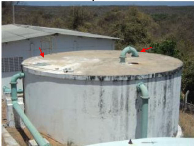
Foto 52 – RAP-01: vista superior - tampa de inspeção e tubulação de ventilação com tela de proteção.
