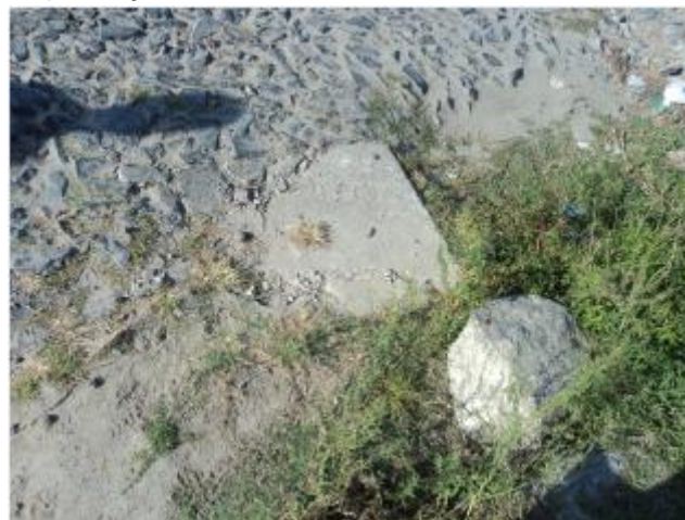
Foto 95 – Registro de descarga na Av. Filomeno de Moraes.
