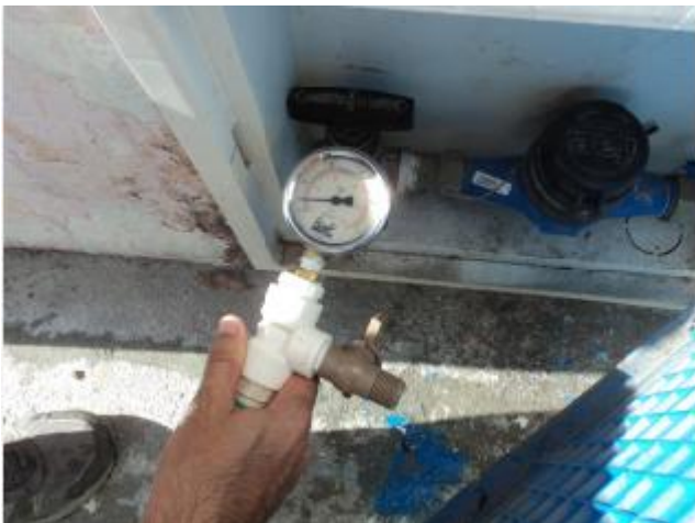
Foto 88 – Medição instantânea de pressão na Av. Filomeno de Moraes.
