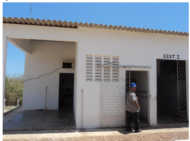
Foto 21 – Casa de química: vista externa.
