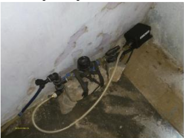
Foto 96 – Medição de pressão contínua na Rua Manoel de Sousa.
