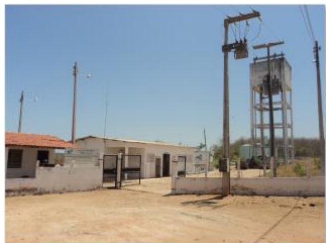
Foto 9 – ETA: área de acesso a ETA.
