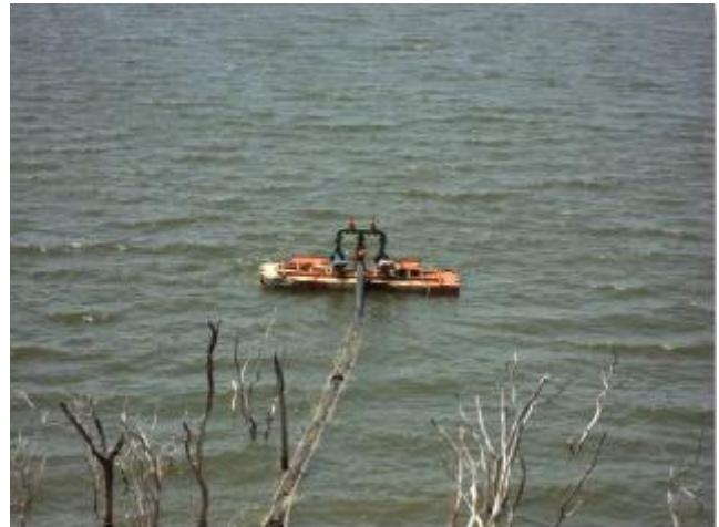
Foto 6 – EECS: conjunto moto-bomba em flutuante.
