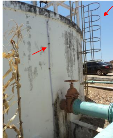
Foto 51 – RAP-01: medidor de nível e escada com guarda-corpo.
