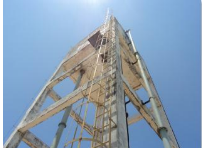
Foto 63 – REL-01: escada de acesso com guarda corpo.
