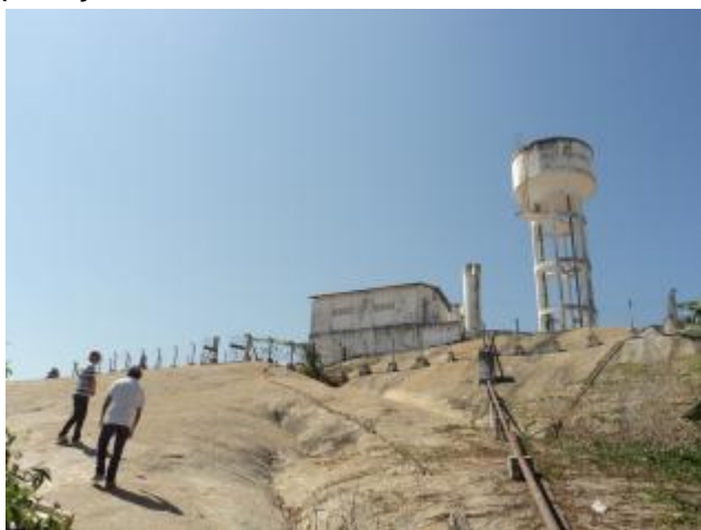
Foto 54 – RAP-02, 03 e REL-03: área de acesso aos reservatórios.
