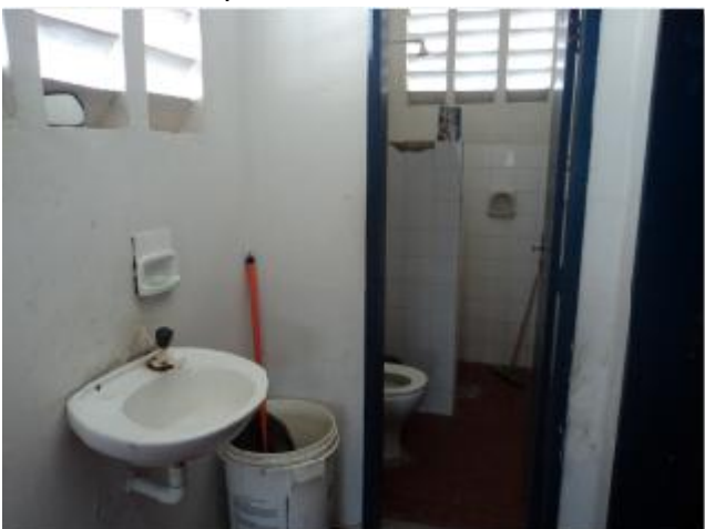
Foto 101 – Loja de atendimento: instalações sanitárias.
