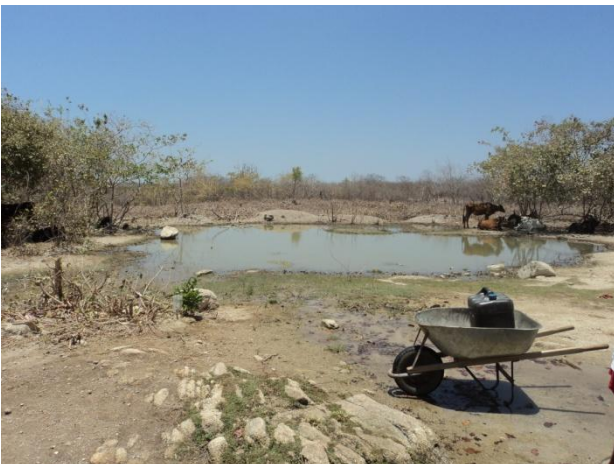
Foto 43 – AAT: lago formado pela água da ventosa danificada (4).
