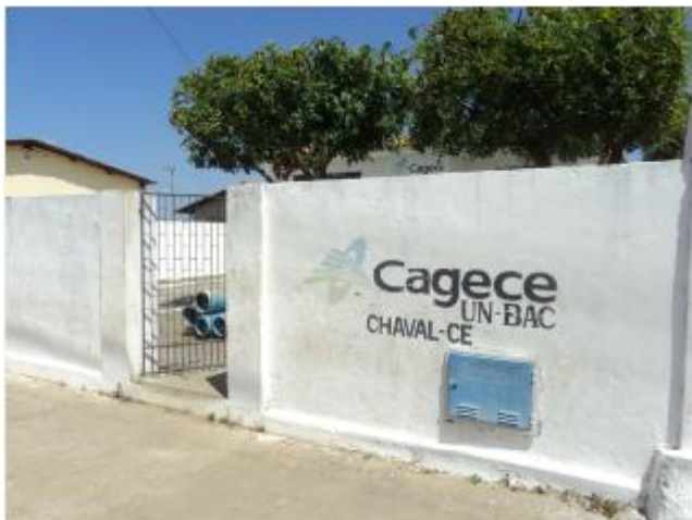
Foto 97 – Loja de atendimento: vista externa.
