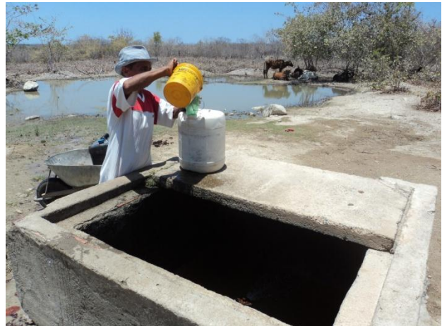
Foto 42 – AAT: retirada de água pelos moradores da região da localidade de Passagem e a Sede de Chaval na caixa da ventosa danificada (4) com acúmulo de água.
