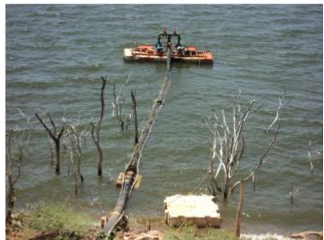
Foto 4 – Açude Itaúna: condições gerais da captação.
