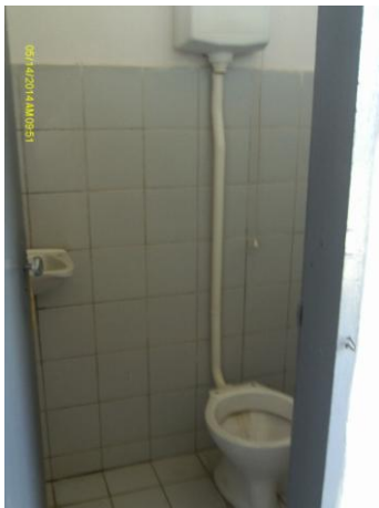
Foto 54 - EEE-01: instalações sanitárias.
