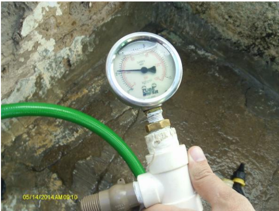
Foto 36 - Medição instantânea de pressão na rede de distribuição: Rua São Pedro, 392.
