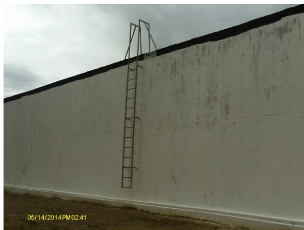
Foto 17 - RAP-01: escada de acesso.
