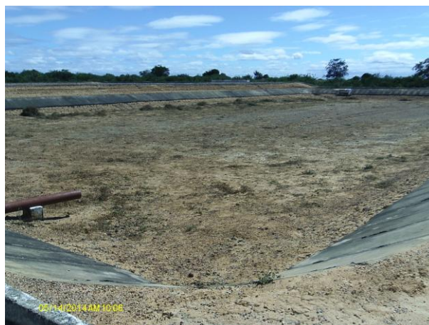
Foto 66 - ETE: lagoa de maturação (2).
