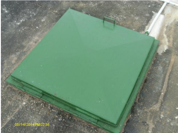
Foto 22 - RAP-01: tampa de inspeção (2).
