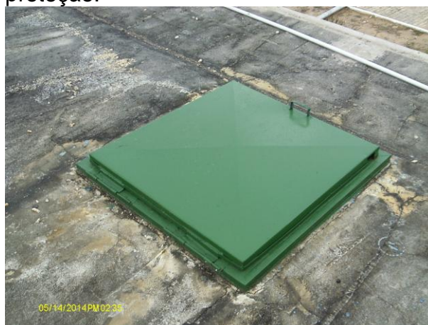
Foto 21 - RAP-01: tampa de inspeção (1).
