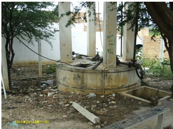
Foto 32 -. REL-02: área de acesso sem delimitação, retirada de água pela comunidade com utilização de bomba submersa.
