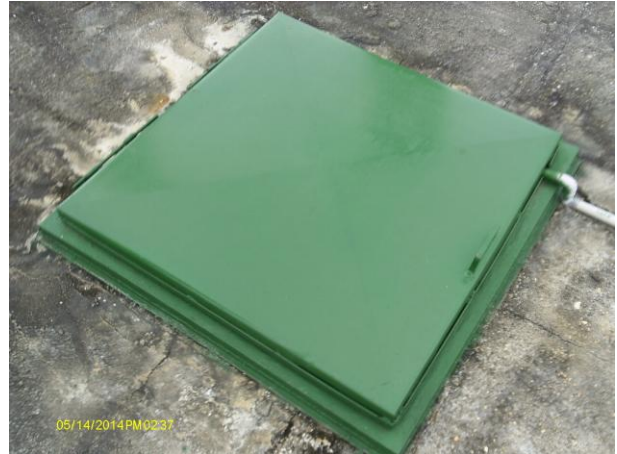
Foto 23 - RAP-01: tampa de inspeção (3).
