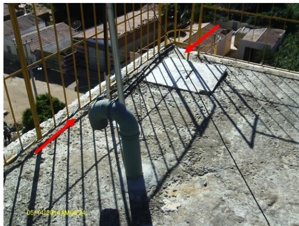
Foto 29 - REL-01: tampa de inspeção sem adequada vedação e tubulação de ventilação sem tela de proteção.
