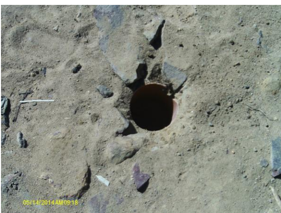
Foto 40 - Registro de descarga na rede de distribuição: Rua João Libânio (sem caixa).
