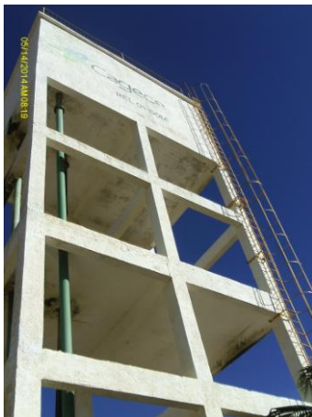
Foto 26 - REL-01: escada de acesso com guarda-corpo.
