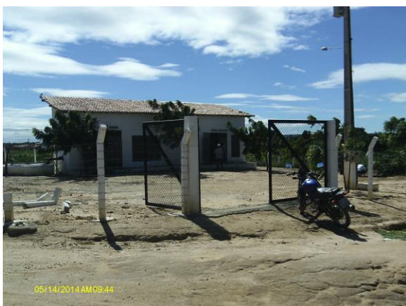
Foto 44 - EEE-01: acesso e delimitação da área.
