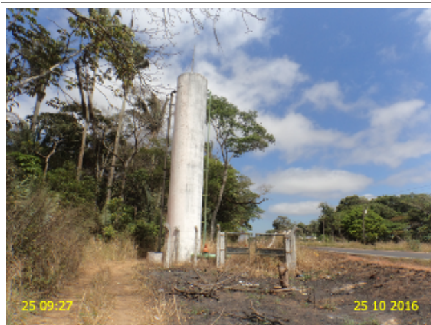
Foto 22 – TAU-10: ausência de sinalizador de obstáculo e excesso de vegetação na área.
