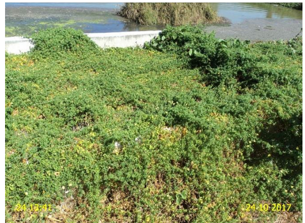
Foto 12 – ETE: vegetação excessiva.
