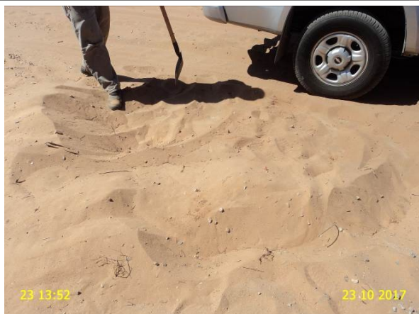
Foto 23 – RDA: registro de descarga soterrado no endereço Rua Boa Esperança.
