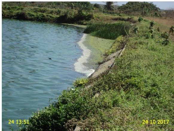
Foto 11 – ETE: acúmulo de sobrenadantes na lagoa de maturação LM(2).
