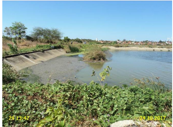
Foto 10 – ETE: acúmulo de sobrenadantes na lagoa facultativa (LF).
