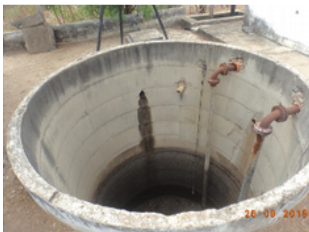
Foto 14 - Elevatória: O poço de sucção da elevatória de esgoto EEE-01 está aberto.
