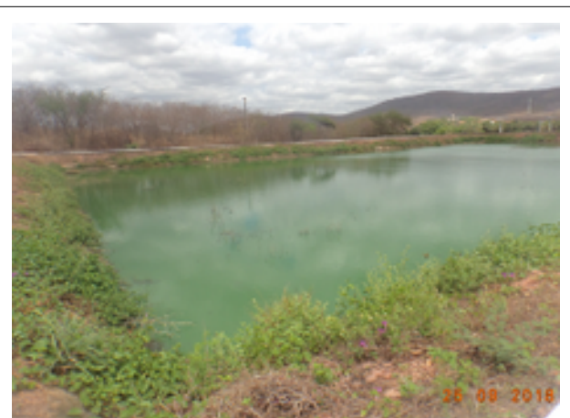
Foto 19 – ETE: A lagoa de maturação apresenta excesso de vegetação nos taludes.
