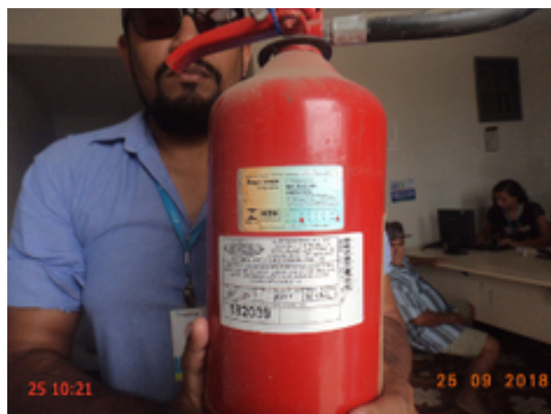
Foto 4 - Comercial: O extintor de incêndio da Loja de Atendimento da Cagece/Almoxarifado está com a recarga vencida.
