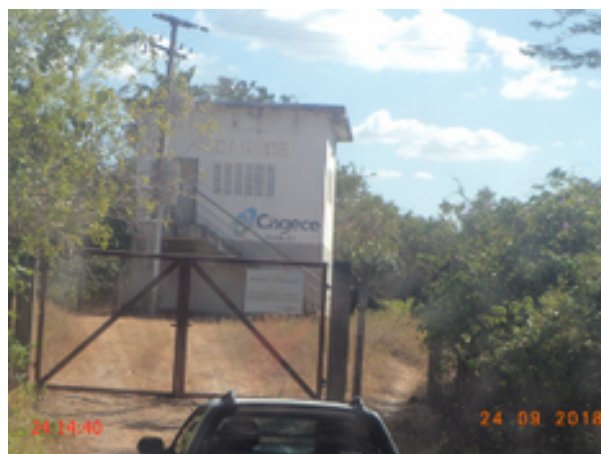
Foto 5 - Captação: ausência de portão para o acesso de pedestres.
