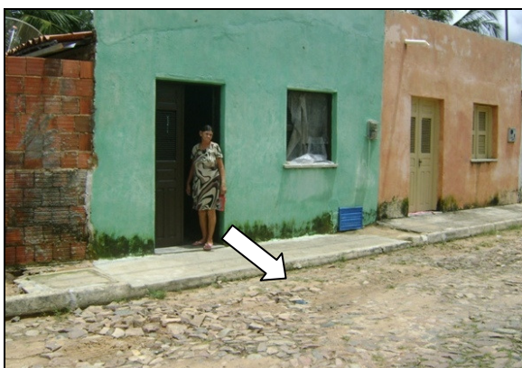
Foto 44 – Registro de descarga sem tampa de proteção, localizado na Av. João José, Roberto Dourado.
