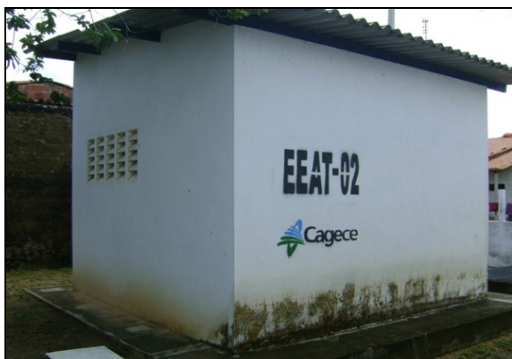
Foto 25 – Prédio de abrigo da EEAT-02.
