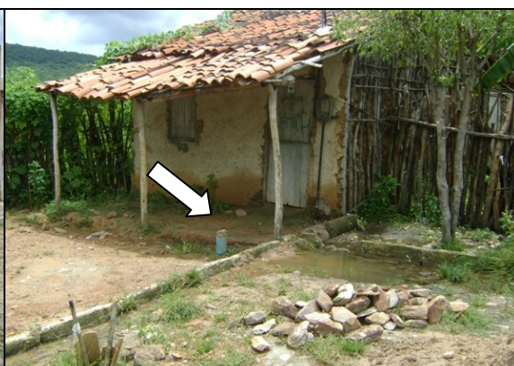
Foto 45 – Registro de descarga sem tampa de proteção, localizado na Av. Brasília, Alecrim.
