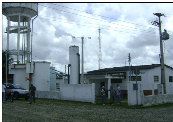
Foto 3 – Entrada da ETA.
