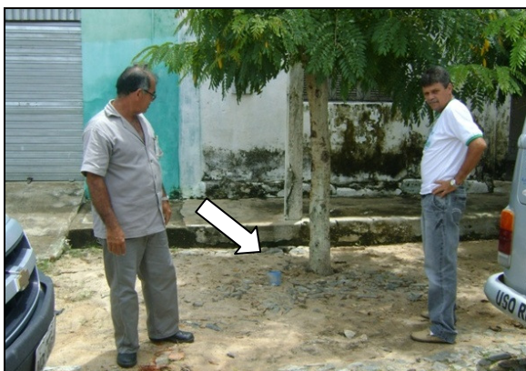
Foto 42 – Registro de descarga sem tampa de proteção, localizado na Rua Maestro Pedro Peixoto, Centro.
