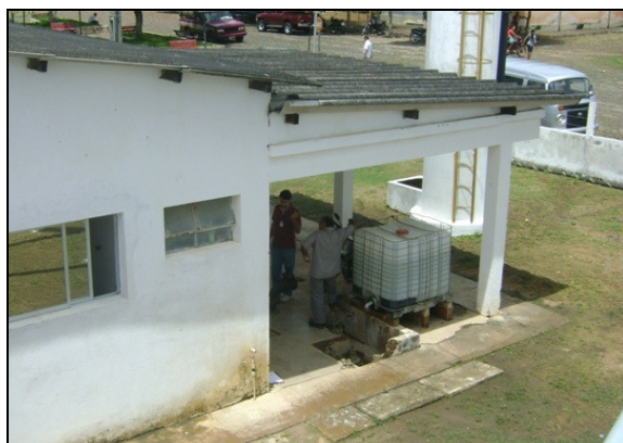
Foto 8 – Vista da casa de química.
