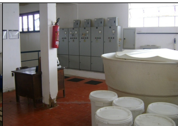
Foto 12 – Extintor de incêndio da ETA.
