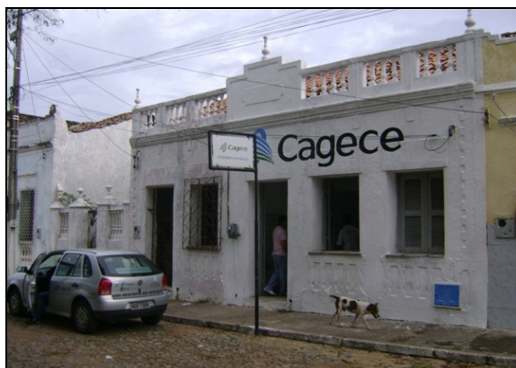
Foto 46 – Vista externa do escritório da CAGECE.
