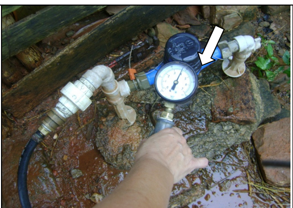
Foto 38 – Medição de pressão na Rua do Matadouro, n°14, antes do hidrômetro.
