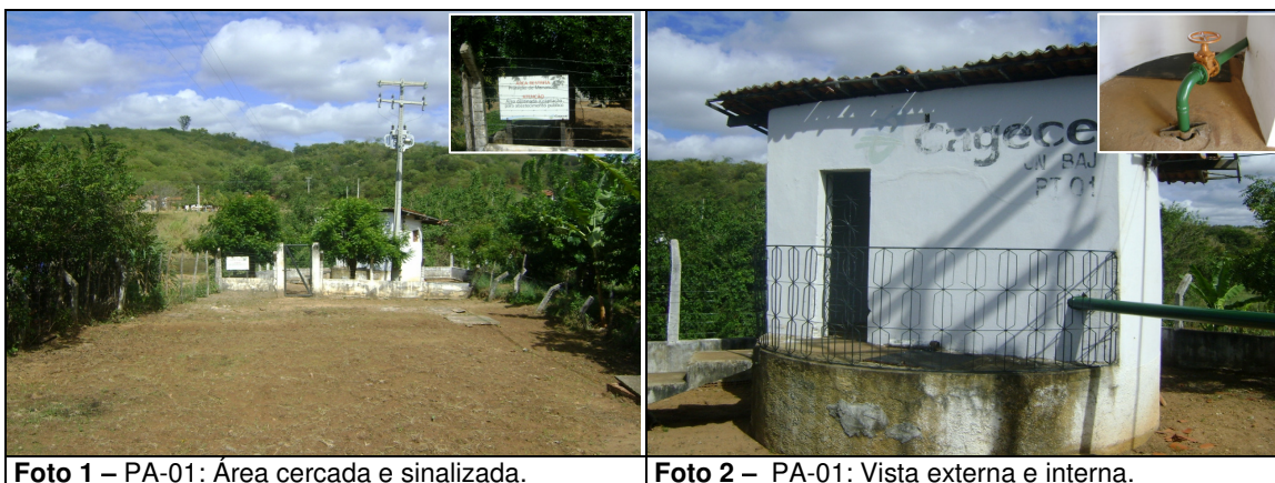
Foto 1 – PA-01: Área cercada e sinalizada.
