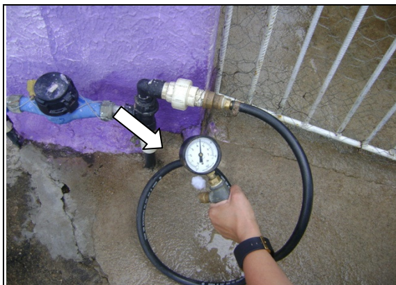
Foto 35 – Medição de pressão na Rua Raul Nogueira, n° 16, Bairro Esplanada.
