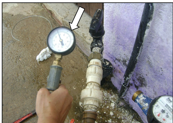
Foto 39 – Medição de pressão na Rua Projetada 18, n° 115, antes do hidrômetro.
