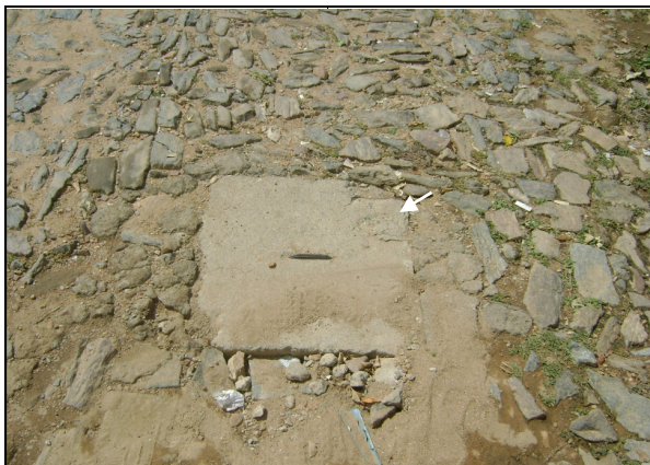
Foto 33 – Registro de descarga localizado na Rua 13 de Março.
