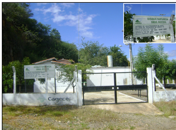
Foto 6 – ETA: Vista externa e placa indicativa do licenciamento ambiental do SAA de Cariús.
