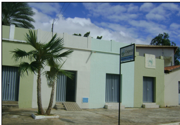
Foto 40 – Vista externa do escritório/loja de atendimento ao usuário.
