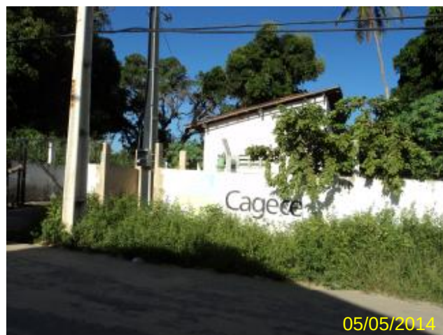
Foto 59 – EERD-01 (Booster): vista externa da elevatória – ausência de identificação.
