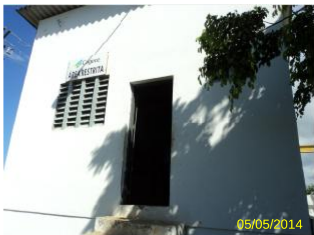
Foto 5 – EEAB-01: casa de abrigo com sinalização de área restrita.
