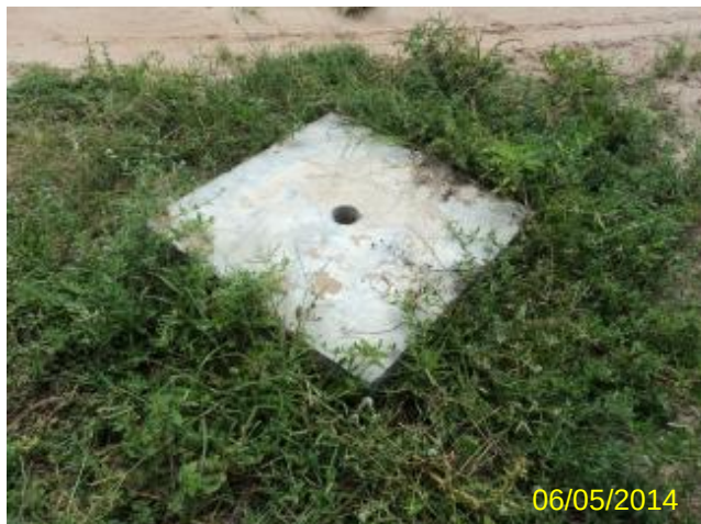
Foto 96 – RDA: registro de descarga na R. Alzira Gomes.
