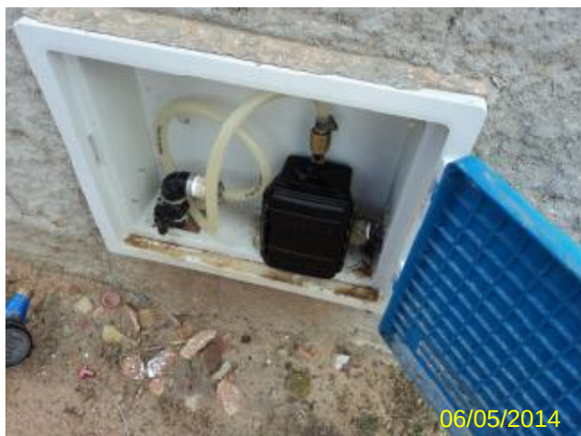
Foto 90 – RDA: medição contínua de pressão na R. Sebastião Xavier, 2084.
