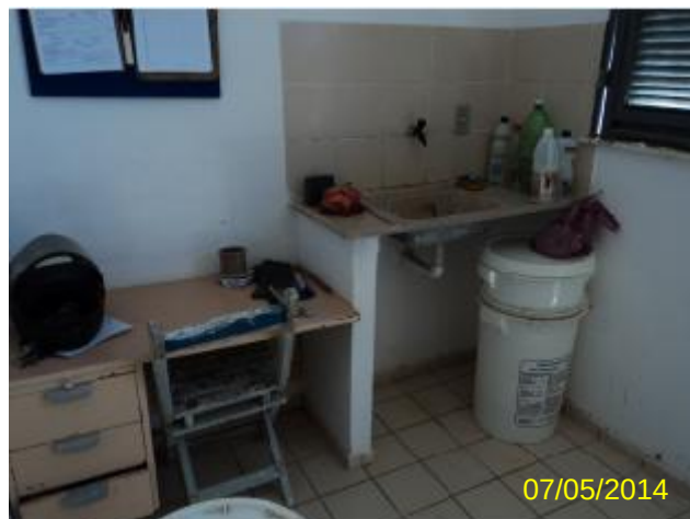
Foto 132 – ETE-Mutirão: vista interna da casa de apoio ao operador.
