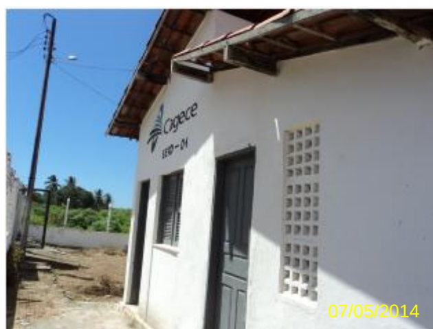
Foto 130 – ETE-Mutirão: casa de apoio ao operador.
