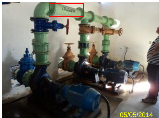
Foto 56 – EELF-01: conjunto moto-bomba com identificação.
