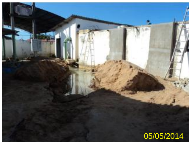
Foto 21 – ETA: pátio externo – realização de obras no RAP-01.
