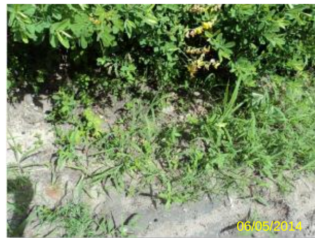
Foto 93 – RDA: registro de descarga na R. José Quariguasil.
