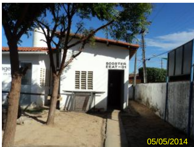
Foto 53 – EEAT-02: identificação incorreta.
