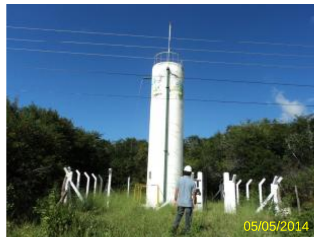
Foto 9 – AAB: caixa de quebra de pressão – vista geral.
