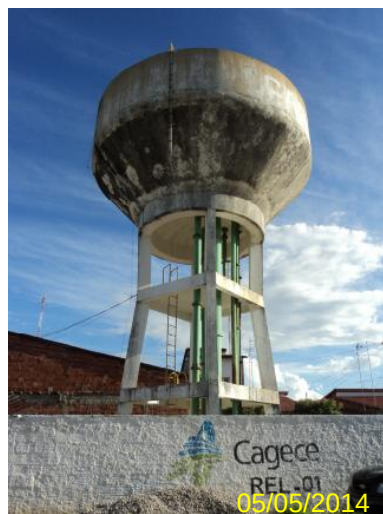
Foto 68 – REL-01: área de acesso e identificação.
