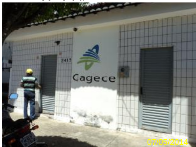
Foto 137 – Loja de atendimento: vista externa.
