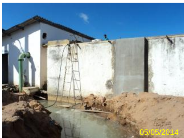
Foto 64 – RAP-01: escada de acesso e realização de reforma no reservatório.
