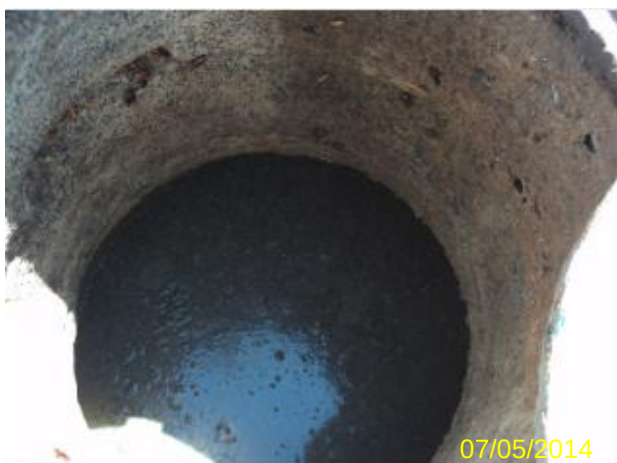
Foto 104 – PV: Trav. Inácio Xavier – vista interna.
