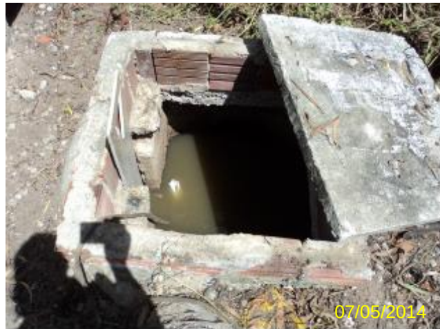
Foto 116 – ETE-Mutirão: poço de chegada do esgoto.
