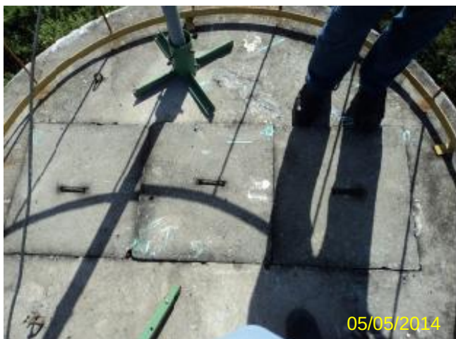
Foto 12 – AAB: caixa de quebra de pressão – tampas de inspeção.
