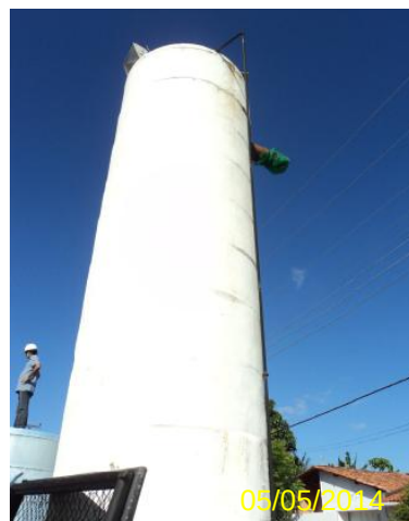
Foto 15 – AAB: torre de equilíbrio.
