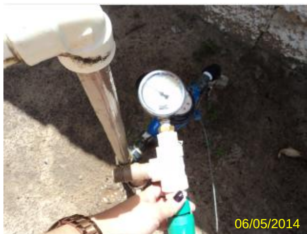
Foto 85 – RDA: medição instantânea de pressão na CE-040, 1953.
