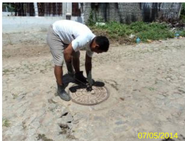
Foto 103 – PV: Trav. Inácio Xavier.
