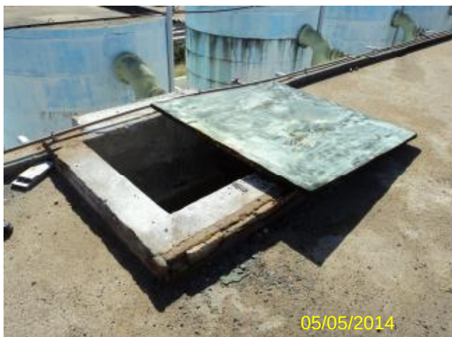
Foto 67 – RAP-01: tampa de inspeção aberta.
