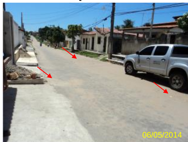
Foto 101 – RDA: R. Padre Maximiniano – problemas frequentes de rompimento da tubulação.
