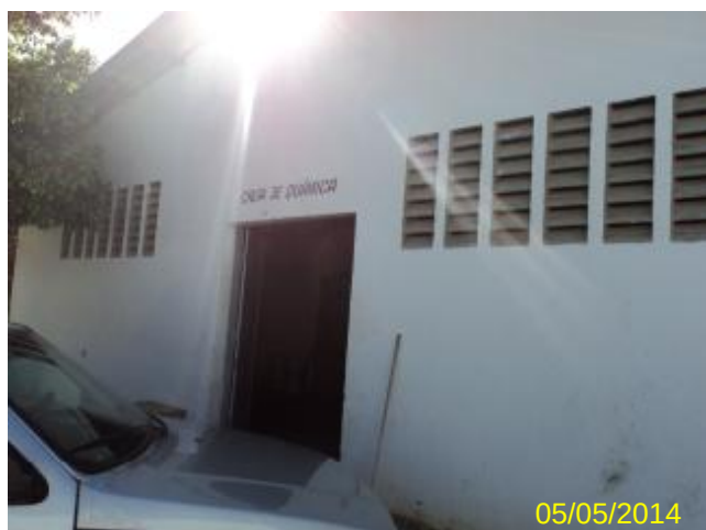
Foto 31 – Casa de química: vista externa.
