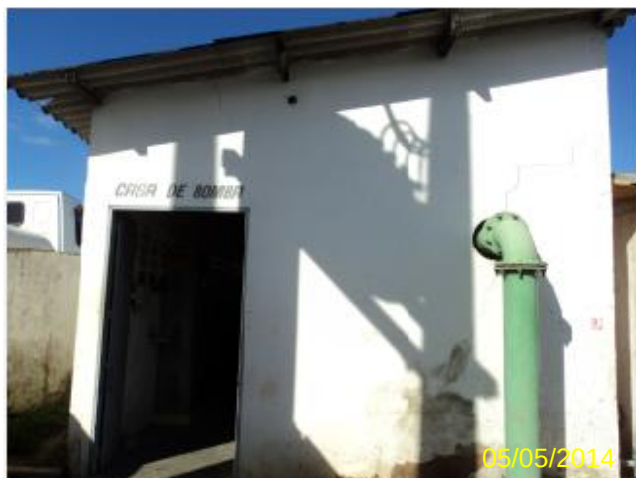
Foto 50 – EEAT-01 e EELF-01: casa de bombas.
