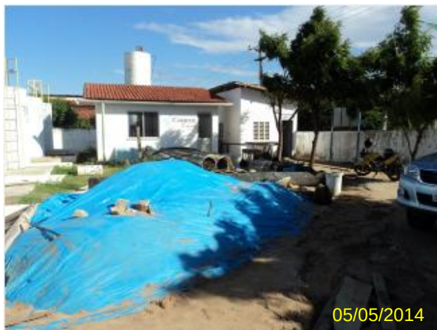
Foto 22 – ETA: pátio externo – realização de obras no RAP-01.
