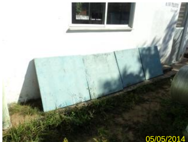
Foto 28 – Filtração: tampas dos filtros.
