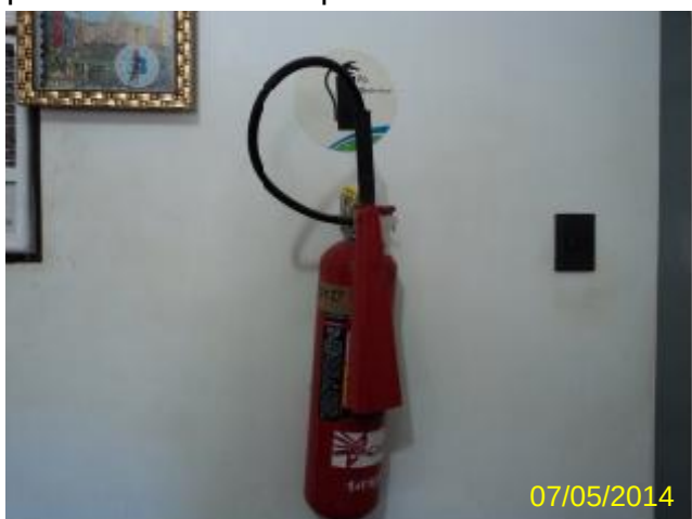
Foto 142 – Almoxarifado: extintor de incêndio.
