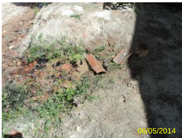
Foto 92 – RDA: registro de descarga na R. Samuel Bede.
