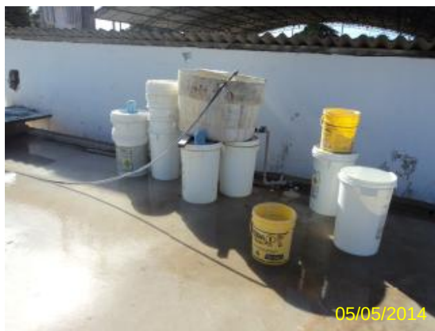
Foto 36 – Casa de química: aplicação de hypocal – tanque localizado em cima do reservatório.
