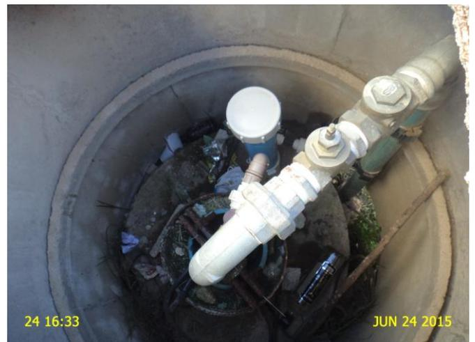
**Foto 9** - PT-11 - Ginásio: laje de proteção aberta e com acúmulo de lixo.
