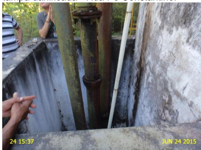
**Foto 25** - RAP-02: caixa de inspeção sem tampa ou grade de proteção.
