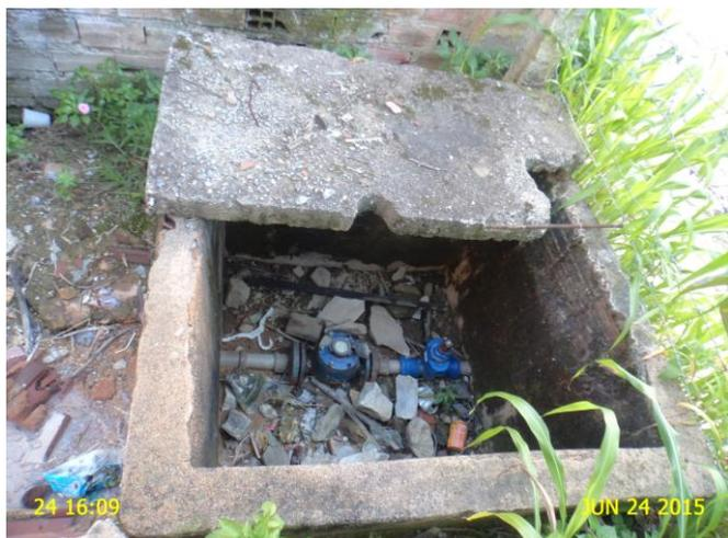
**Foto 10** - PT-06: caixa do macromedidor sem tampa.
