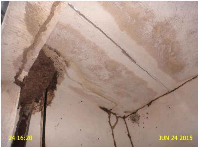
**Foto 6** - PT-Buracão: presença de cupins na parede da casa de abrigo do QC.
