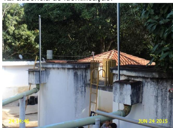
**Foto 14** - F-01 e F-02: ausência de identificação, pintura deteriorada, tampas em processo de corrosão.
