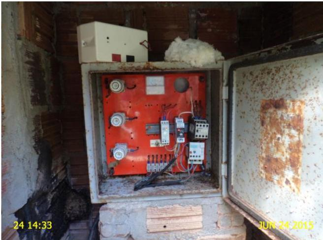
**Foto 2** - PA-02: ausência de horímetro instalado no QC.
