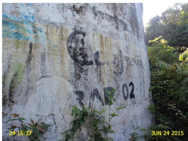
**Foto 27** - RAP-02: identificação pouco visível e pintura deteriorada.
