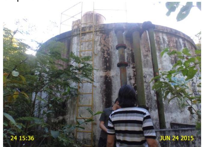
**Foto 5** - RAP-02: ausência de sistema de medição de nível.
