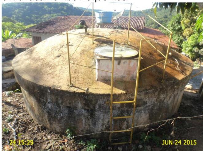
**Foto 24** - RAP-03: ausência de identificação, pintura deteriorada, tampa sem vedação e escada de acesso em corrosão.
