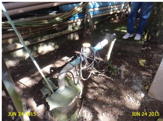
**Foto 11** - PT-01: tampa de proteção inadequada.
