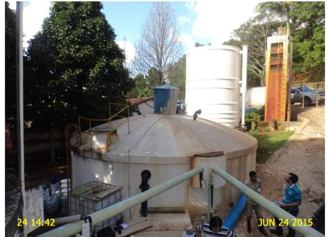
**Foto 3** - RAP-01: ausência de identificação, pintura deteriorada, tampa de inspeção, tubulação de ventilação inadequada e guarda corpo em corrosão.
