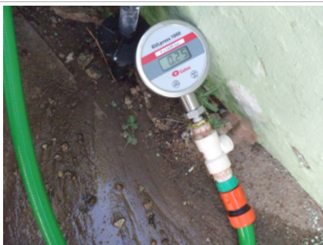
Foto 15 - Medição instantânea de pressão no endereço localizado na Rua 15 de Agosto, 43.
