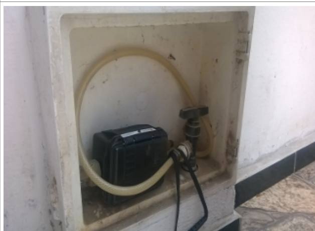
Foto 16 - Aparelho de medição contínua de pressão (datalogger) instalado no endereço localizado na Rua Isaac de Castro, 218.
