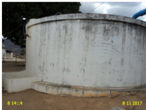
Foto 27 – RAP-02 (Brotas): pintura deteriorada e ausência de identificação.
