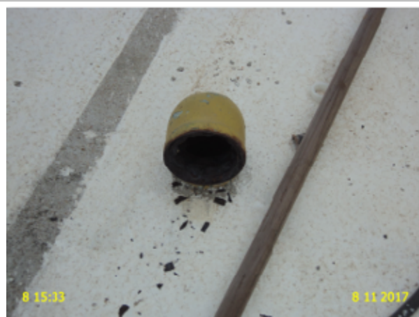
Foto 27 – RAP-02 (Brotas): pintura deteriorada e ausência de identificação.
