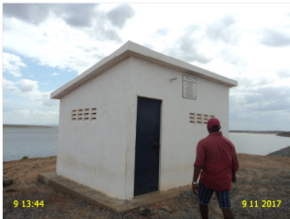
Foto 8 – EECS: ausência de identificação.
