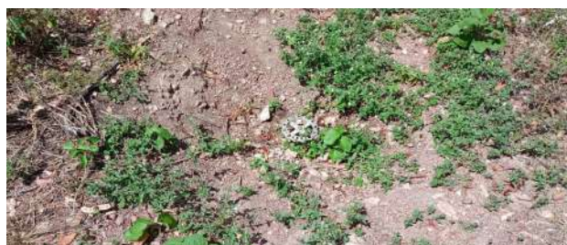
Foto 26 - RAP-04: Registro sem caixa de proteção.
