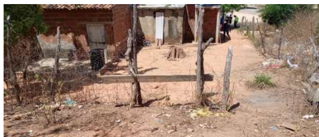
Foto 24 - RAP-04: acesso difícil, caixas sem tampas e infraestrutura de isolamento da área danificada.
