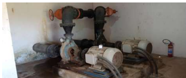
Foto 15 - EAB-01: Bomba com vazamento.
