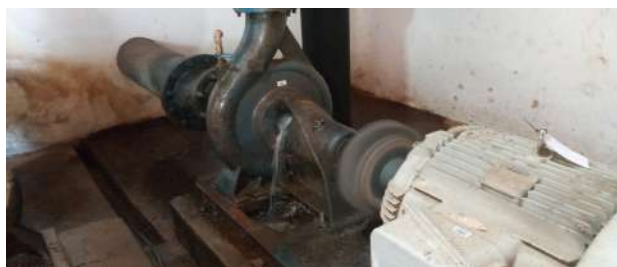
Foto 15 - EAB-01: Bomba com vazamento.
