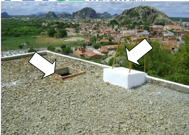
Foto 56 – Ventilações do RAP-03. Foto 57 – Visita e escada
