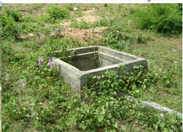
Foto 65 – Caixa de ventosa na adutora de água bruta.
