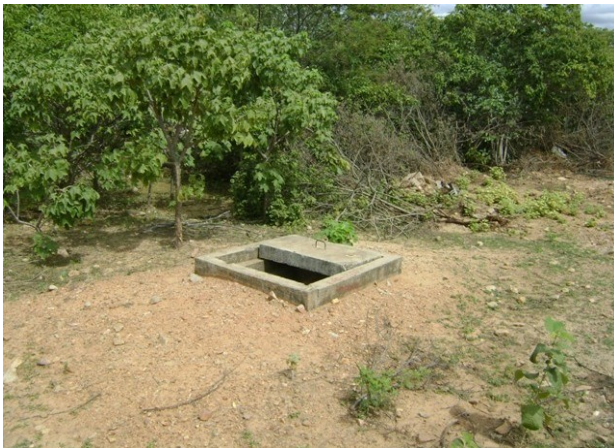
Foto 65 – Caixa de ventosa na adutora de água bruta.
