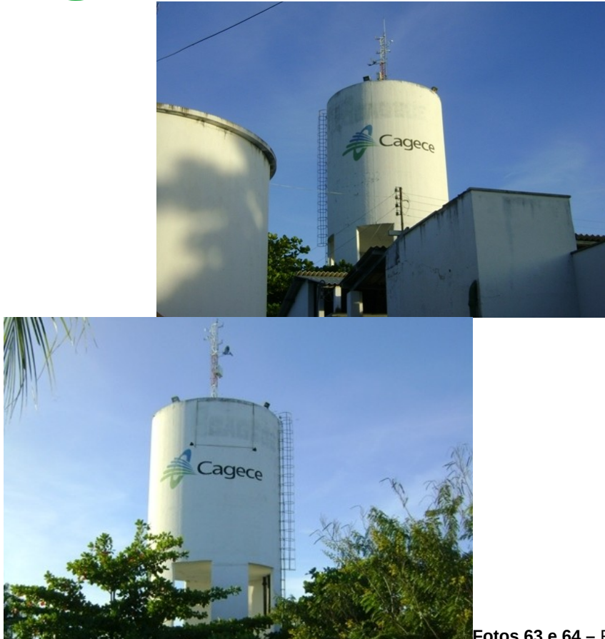
Fotos 63 e 64 – Reservatório REL-01.
