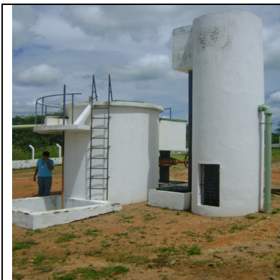
Foto 7 – Vista da torre de equilíbrio e do filtro
