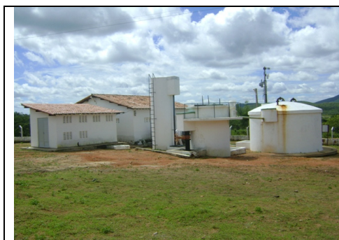
Foto 5 – Vista da ETA do SAA de Arneiroz
