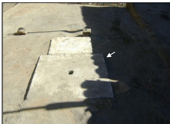
Foto 45 – Registro de descarga localizado na Rua Francisco Chagas Cavalcante.
