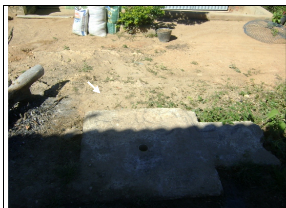
Foto 43 – Registro de descarga localizado na Rua Adauto Silva.
