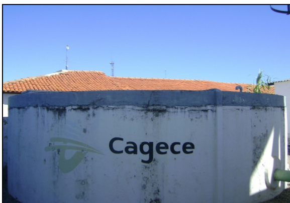
Foto 33 – RAP-02: Existência de identificação.
