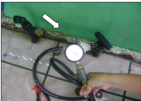
Foto 50 – Medição de pressão na Praça Visconde de Icó, antes do hidrômetro.
