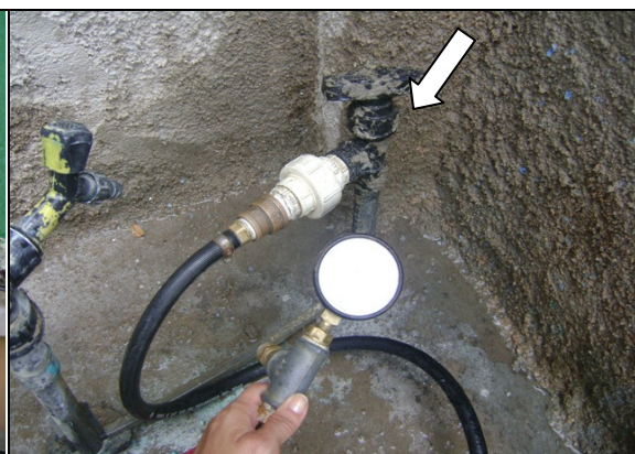
Foto 51 – Medição de pressão na Rua Manoel de Paula Fernandes, nº 433, antes do hidrômetro.
