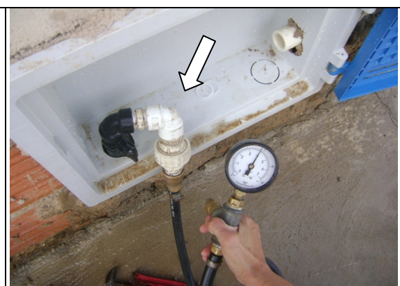
Foto 53 – Medição de pressão na Rua Fernando Bastos, nº 500, antes do hidrômetro.
