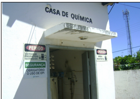
Foto 5 – Casa de química: Vista externa.
