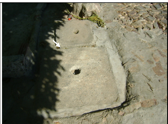
Foto 42 – Registro de descarga localizado na Rua Elizeu Herbert.
