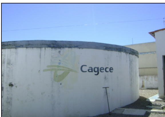
Foto 29 – RAP-01: Existência de identificação.
