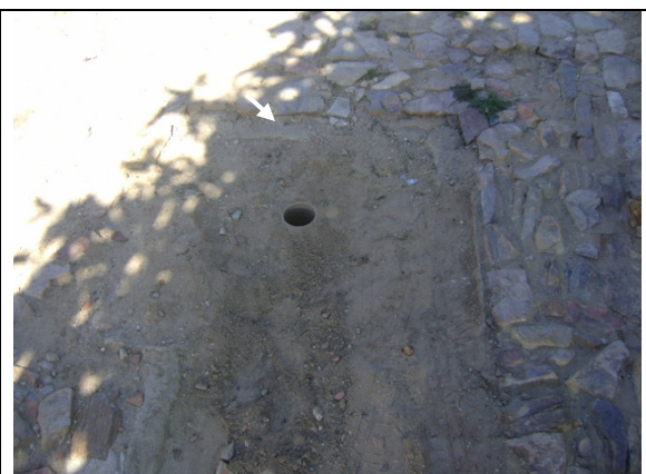
Foto 46 – Registro de descarga localizado na Rua Poço do Serrote.
