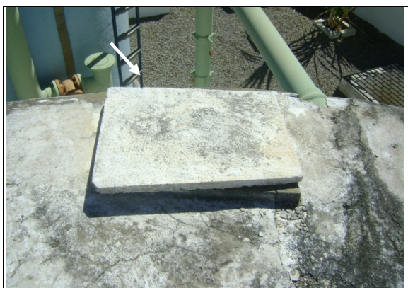
Foto 31 – RAP-01: Tampa de visita adequada.
