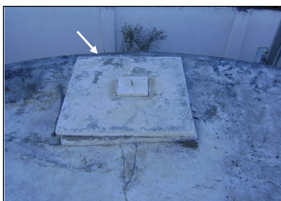
Foto 35 – RAP-02: Tampa de visita adequada.
