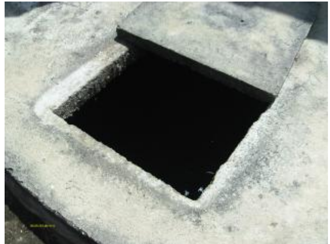
Foto 53 – EEE: poço de sucção.
