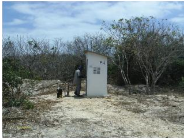
Foto 8 – PT-04: identificação, área de acesso sem delimitação e ausência de iluminação para trabalhos noturnos.
