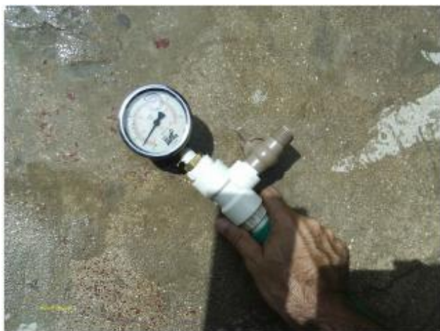
Foto 45 – RDA: medição instantânea de pressão na Rua 7 bocas, FNS 463.
