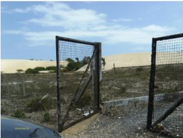
Foto 59 – Área de acesso a ETE e ausência de identificação.
