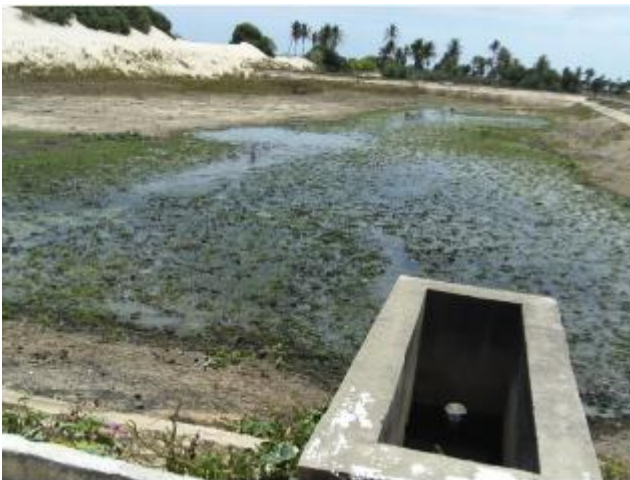
Foto 67 – Vista geral da lagoa facultativa.
