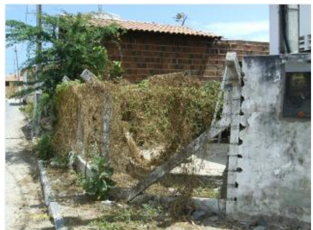
Foto 51 – EEE: cerca de proteção.
