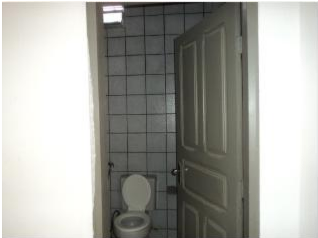
Foto 75 – Loja de atendimento: instalações sanitárias.
