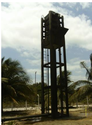
Foto 21 – Aeração: aerador desativado.
