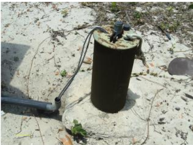
Foto 15 – PT-06 (proteção): proteção do poço.
