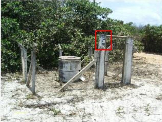
Foto 1 – PT-01 (desativado): área de acesso delimitada, identificação e ausência de iluminação noturna.
