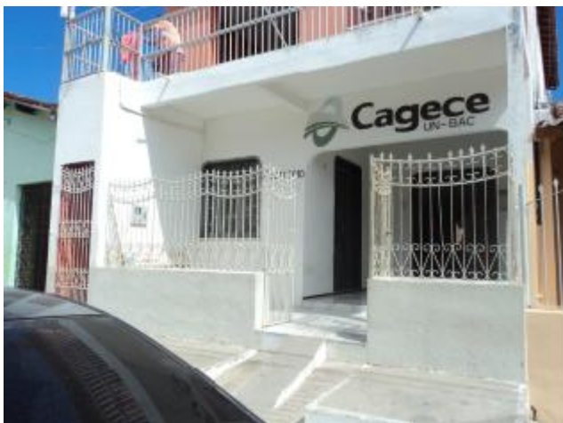
Foto 71 – Loja de atendimento: vista externa.
