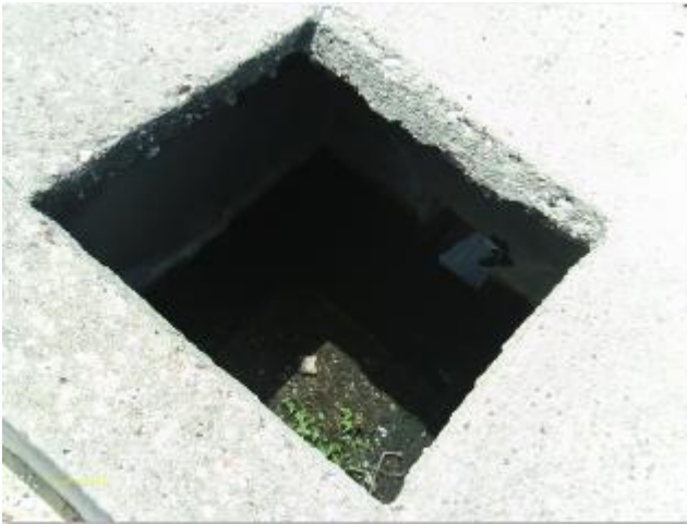
Foto 65 – Caixa de saída para a lagoa de estabilização.
