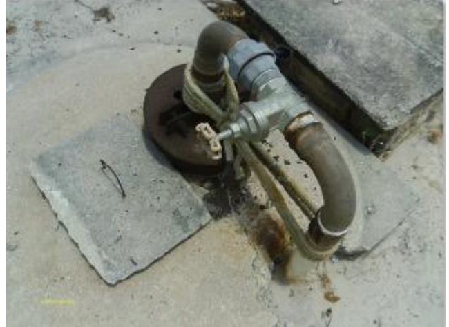
Foto 6 – PT-03: laje de proteção.
