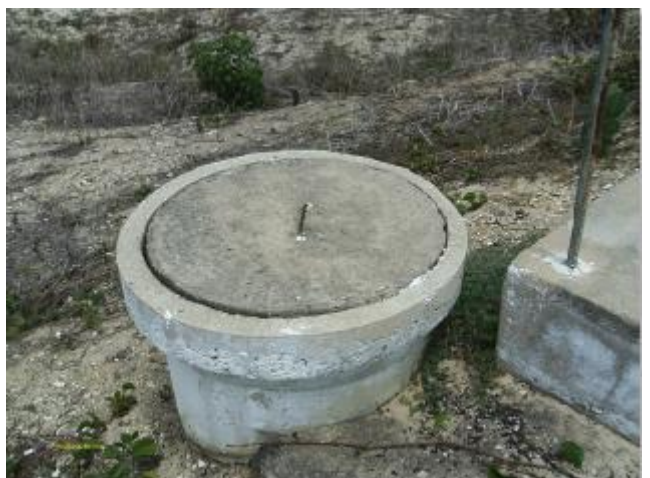
Foto 62 – Poço de chegada.
