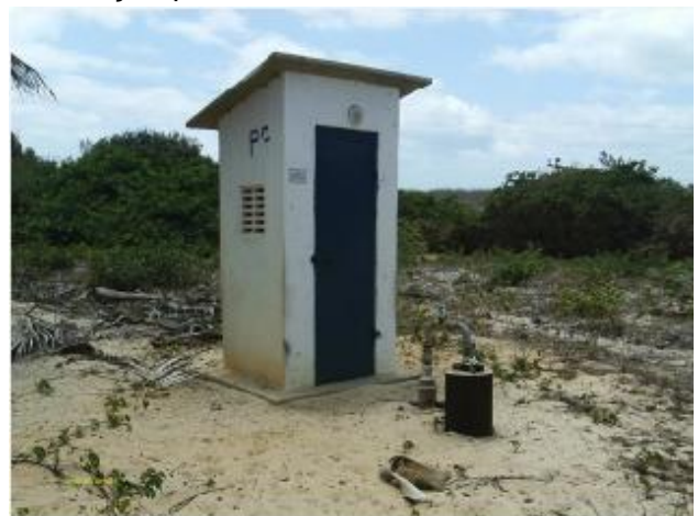
Foto 16 – PT-07: identificação, área de acesso sem delimitação e ausência de iluminação para trabalhos noturnos.
