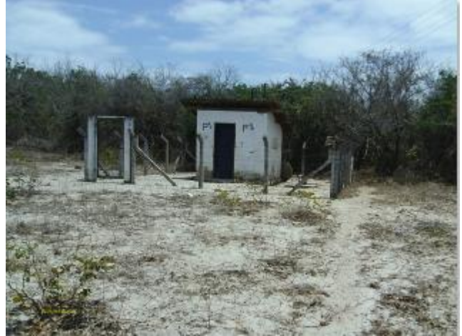
Foto 2 – PT-02 (desativado): área de acesso delimitada e ausência de iluminação para trabalhos noturnos.
