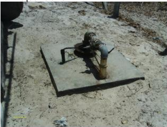
Foto 3 – PT-02 (desativado): laje de proteção.
