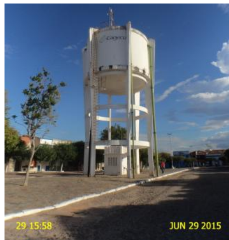
Foto 6 – REL-01: área de acesso sem delimitação.
