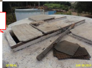
Foto 10 – Filtrros F.01 e F.02: tampas inadequadas.
