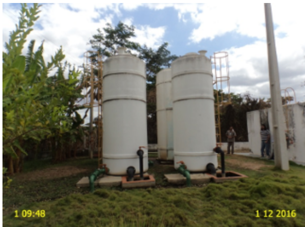
Foto 24 – ETA São Joaquim: os filtros F-01, F-02, F-03, F-04 não estão identificados.
