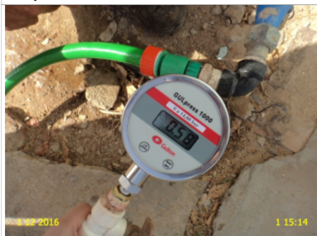
Foto 3 - RDA: medição instantânea de pressão no endereço localizado na Rua São Francisco, S/N.
