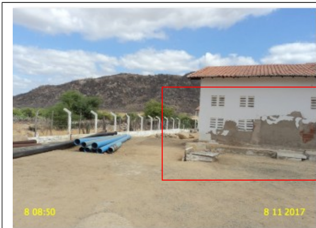
Foto 3 – ETA: parede com reboco e pintura deteriorados.
