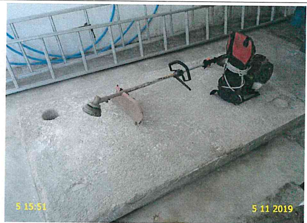
Foto 3 - EEE-06: Base do grupo gerador de energia elétrica.
