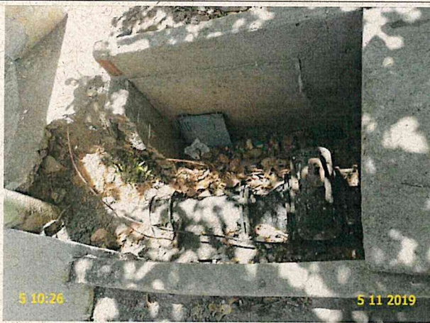
Foto 46 - REL-01: caixa de inspeção sem tampa ou grade de proteção.
