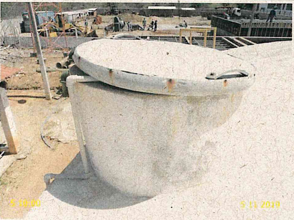
Foto 46 - REL-01: caixa de inspeção sem tampa ou grade de proteção.
