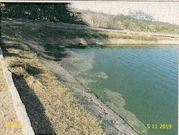
Foto 25 - ETE: acúmulo de sobrenadantes na lagoa facultativa.
