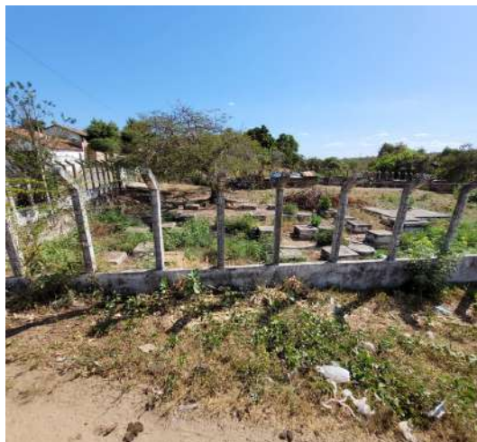
Foto 18 - Esgoto: lançamento in natura.
