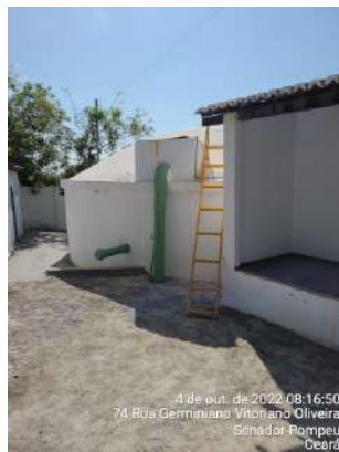
Foto 7 - ETA: RSE-01 sem identificação.
