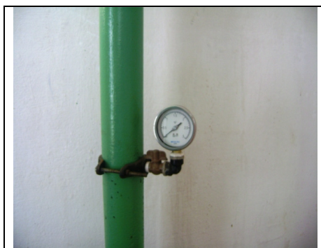
Foto 23 – Medição de nível do REL-01
