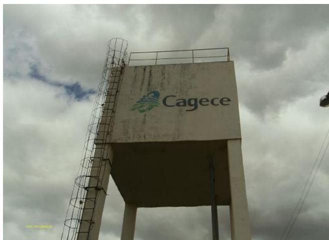
**Foto 55** - REL-01: escada de acesso e pintura deteriorada.
