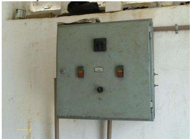
**Foto 39** - *Booster Nova Hidrolândia*: quadro de comando sem horímetro.
