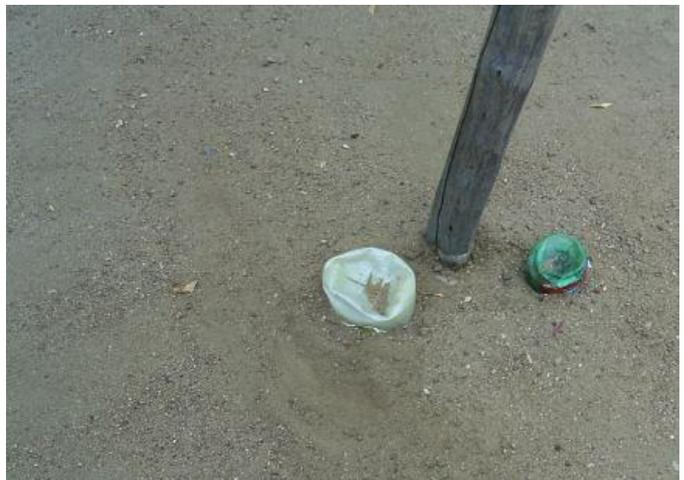
**Foto 67** - Registro de descarga na rede de distribuição: Rua Elmiro de Sousa – soterrado.
