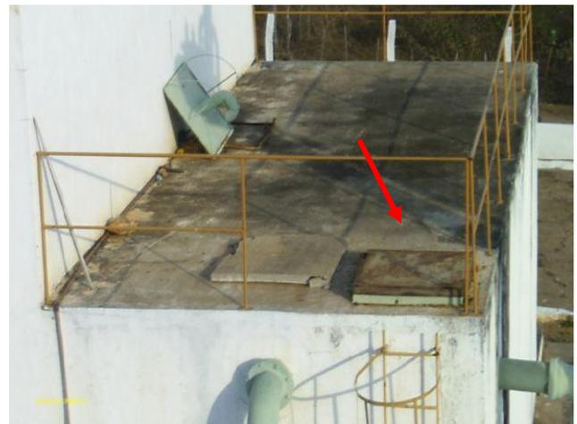
**Foto 45** - RAP-02: tampa de inspeção em processo de corrosão.
