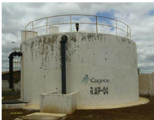
**Foto 50** - RAP-04: pintura deteriorada, identificação, guarda-corpo.
