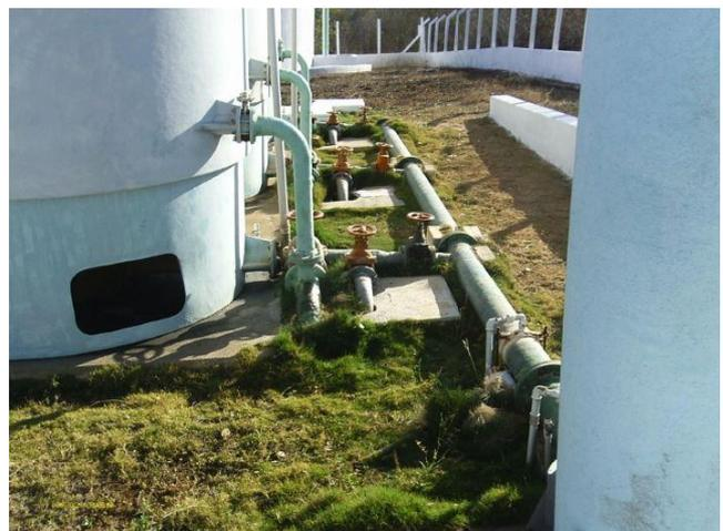
**Foto 9 - Filtros F-01, F-02 e F-03:** tubulação de entrada de água e registros.
