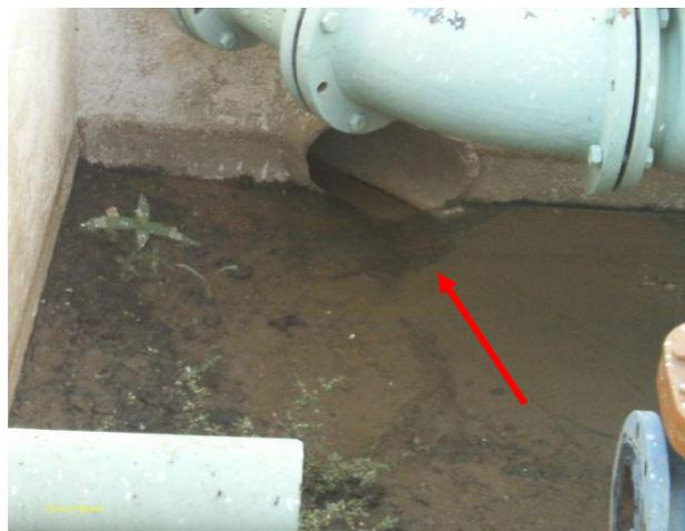
**Foto 13** - Manilha para saída da água de lavagem dos filtros.
