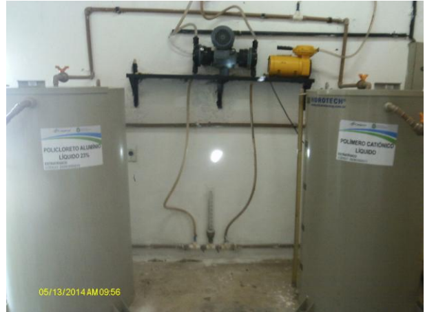
Foto 26 - ETA/Casa de química: tanques de dosagem de PAC e polímero.
