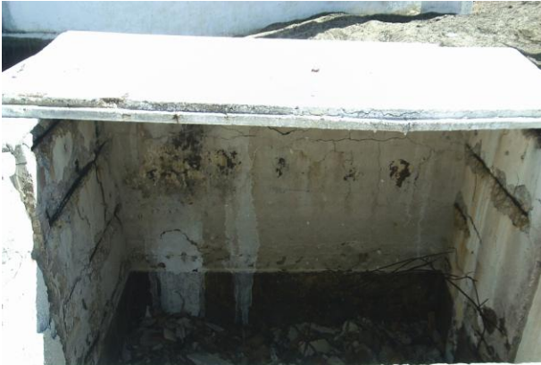
Foto 25 - ETA: tanque de cloração desativado com tampa danificada e acúmulo de lixo na parte interna.
