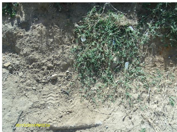
Foto 86 - Registro de descarga na rede de distribuição: Rua Nova (soterrado).
