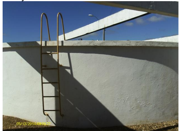
Foto 22 - ETA/Filtração: escada de acesso do F-02.
