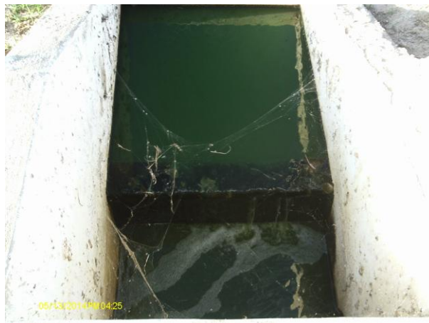
Foto 139 - ETE: saída do esgoto para lagoa de maturação I.
