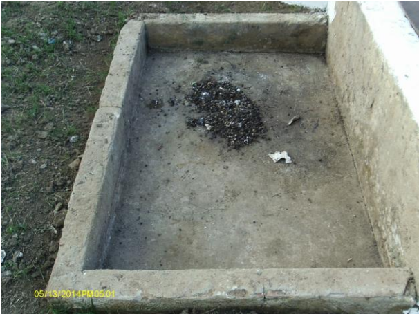
Foto 104 - EEE-01: caixa de areia.
