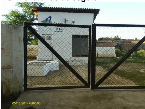
Foto 96 - EEE-01: delimitação e acesso.
