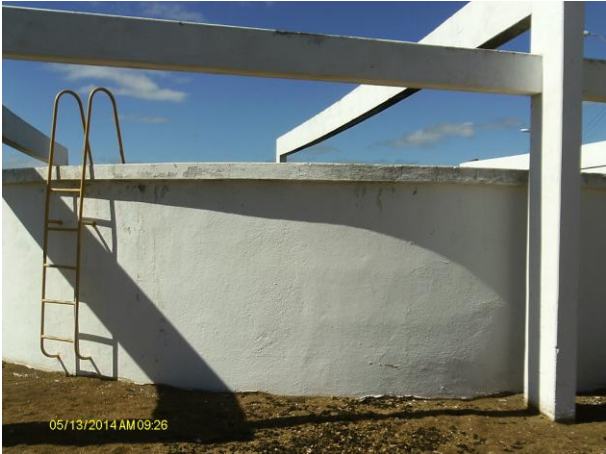
Foto 19 - ETA/Filtração: escada de acesso do F-01.
