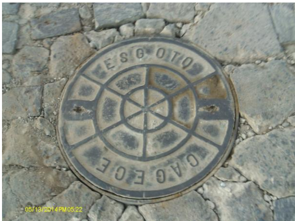
Foto 92 - PV localizado na Rua Coronel Baleco (recebe contribuição da EEE-01).
