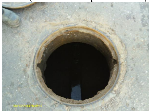
Foto 95 - PV localizado na Rua João Severo Cortez (recebe contribuição da EEE-02).
