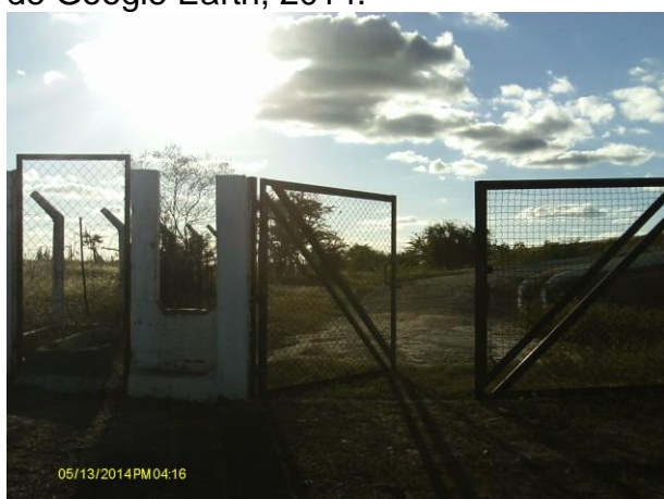
Foto 132 - ETE: delimitação, acesso e ausência de identificação.
