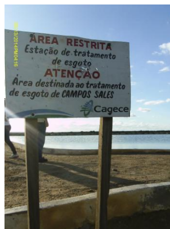
Foto 131 - ETE: placa indicativa de área destinada ao tratamento de esgoto.
