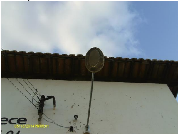
Foto 100 - EEE-01: sem iluminação externa.
