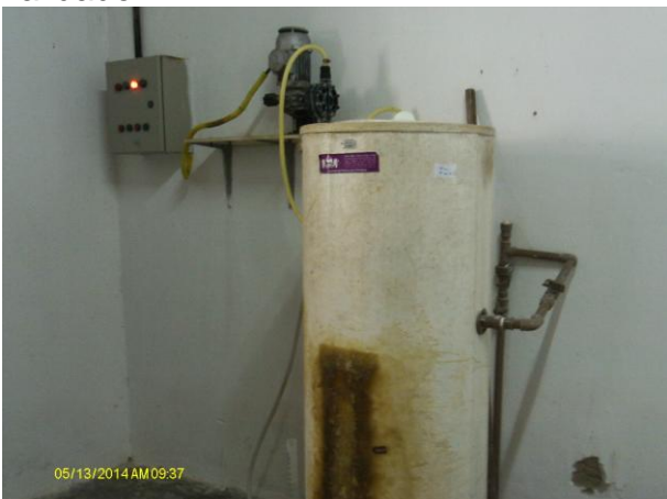
Foto 29 - ETA/Casa de química: tanque dosador de flúor.
