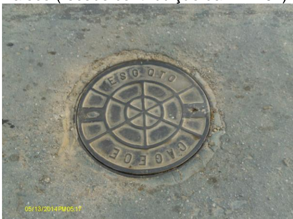
Foto 94 - PV localizado na Rua João Severo Cortez (recebe contribuição da EEE-02).
