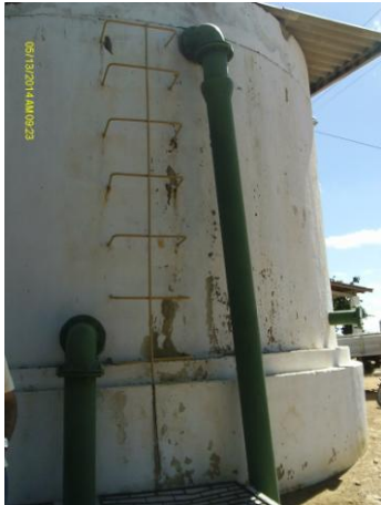
Foto 13 - ETA/Filtração: escada de acesso do pré-filtro.
