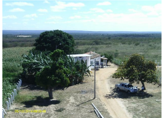
Foto 8 - ETA: vista do pátio externo.
