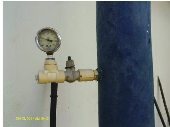
Foto 76 - REL-02: medidor de nível.
