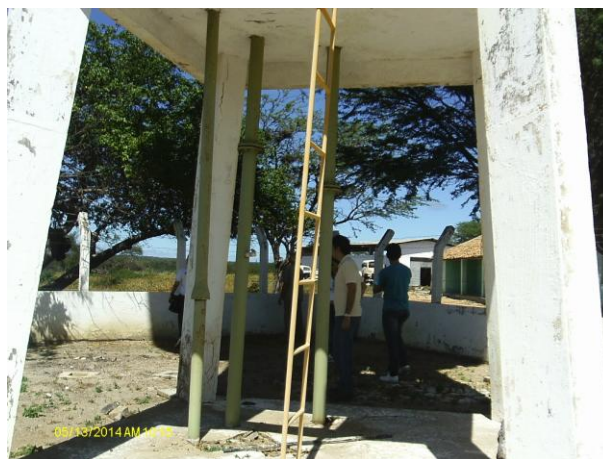
Foto 70 - REL-03: escada de acesso.
