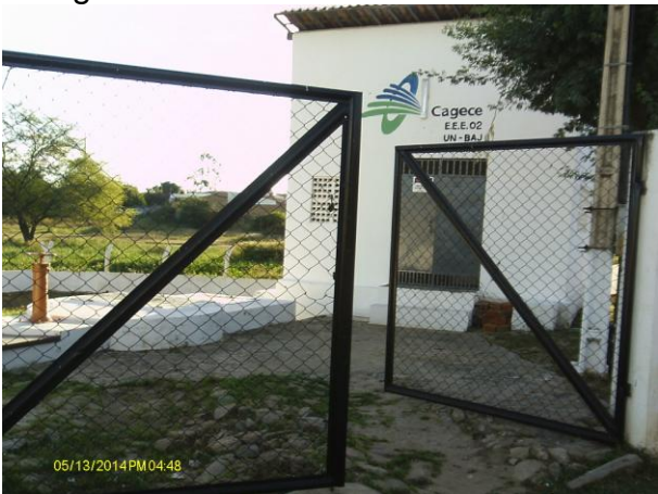
Foto 108 - EEE-02: delimitação e acesso.
