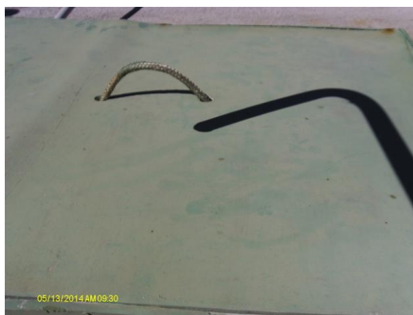
Foto 60 - RAP-01: tampa de inspeção.
