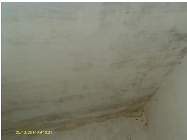
Foto 58 - EERD-02: sem iluminação na casa de abrigo.
