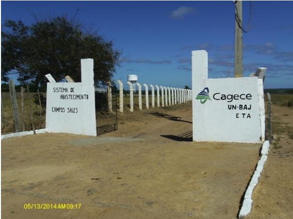
Foto 7 - ETA: identificação, acesso e delimitação.
