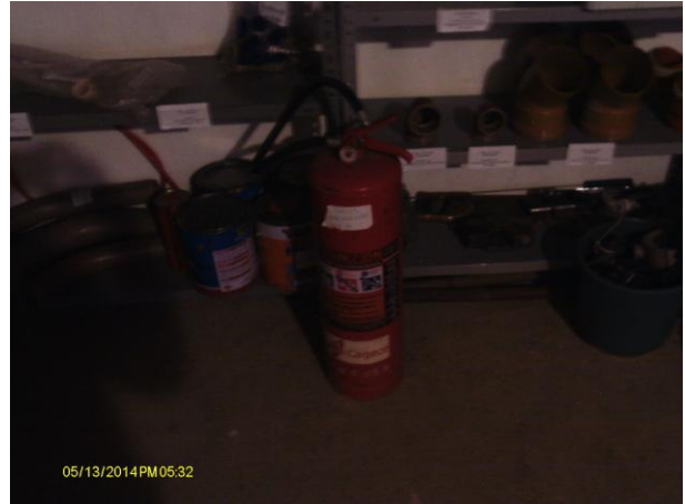
Foto 165 - Comercial/almoarifado: extintor de incêndio.
