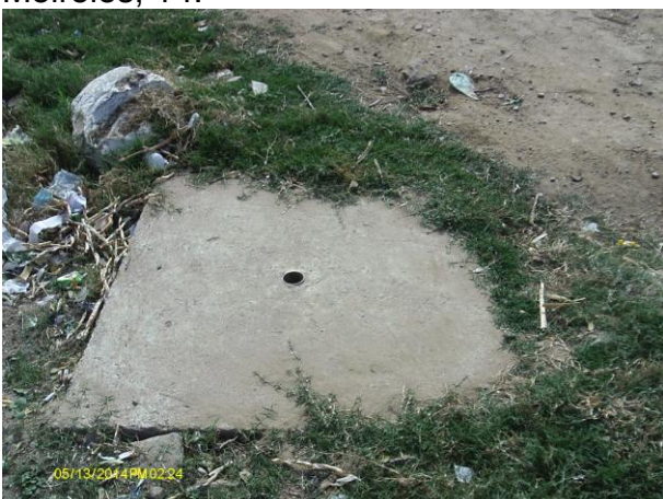
Foto 85 - Registro de descarga na rede de distribuição: Rua da Lavanderia.
