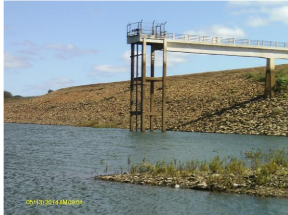
Foto 2 - Captação superficial por gravidade na parede do Açude Poço da Pedra.
