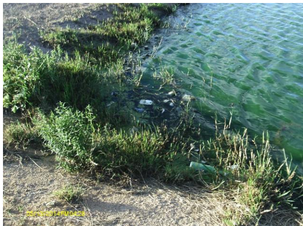
Foto 146 - ETE: lixo acumulado na lagoa de maturação I.
