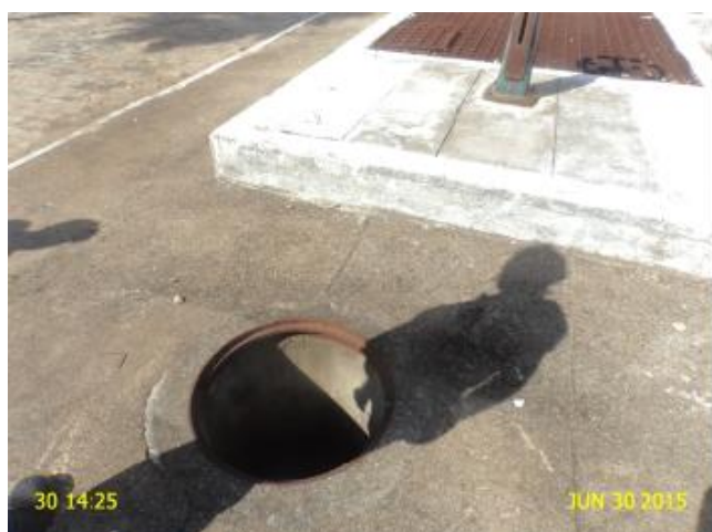
Foto 18 – EEE-02: poço de visita na chegada da elevatória sem tampa.
