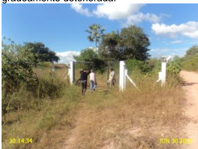
Foto 19 – ETE: ausência de identificação.
