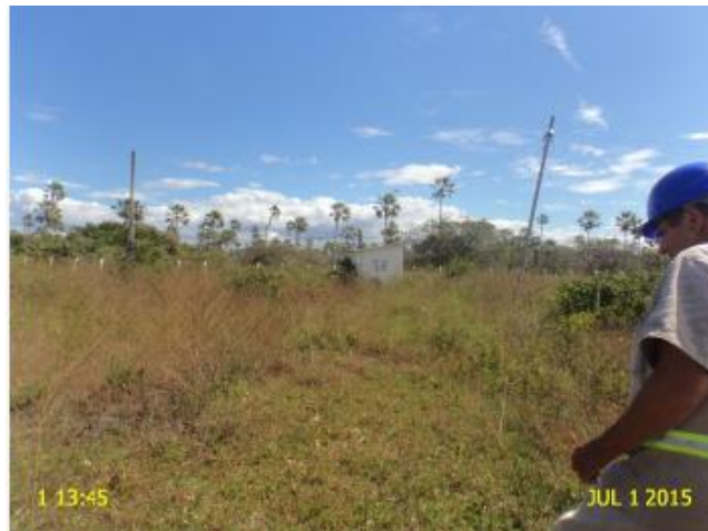
Foto 2 - PT-01, PT-02, PT-07, PT-08 e PT-09: área de acesso com excesso de vegetação.
