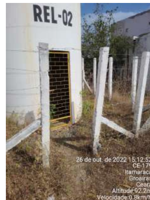
Foto 20 - REL-02: cerca sem portão.
