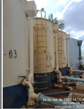
Foto 6 - ETA: as escadas dos Filtros estão corroídas e sem estabilidade. O F-04 não possui identificação e tampa.
