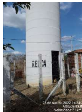
Foto 14 - REL-04: cerca sem portão e escada corroída.
