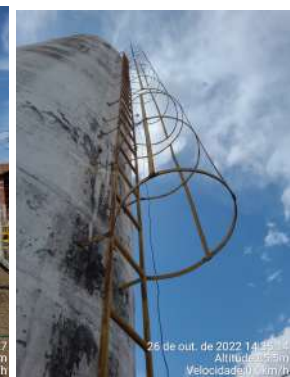
Foto 14 - REL-04: cerca sem portão e escada corroída.
