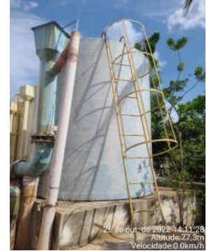
Foto 6 - ETA: as escadas dos Filtros estão corroídas e sem estabilidade. O F-04 não possui identificação e tampa.
