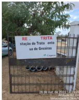
Foto 13 - ETA: placa da entrada parcialmente apagada.
